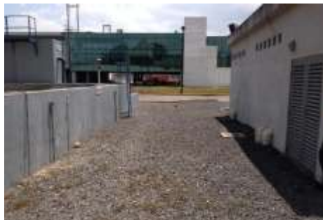
Figura 37. Planta de tratamiento de aguas residuales P1
