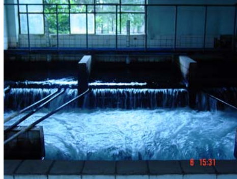
Figura 28. Vertedero de salida
