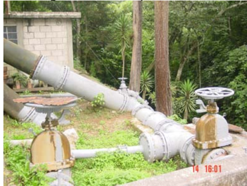
Figura 10. Compuertas Teocinte I y II
