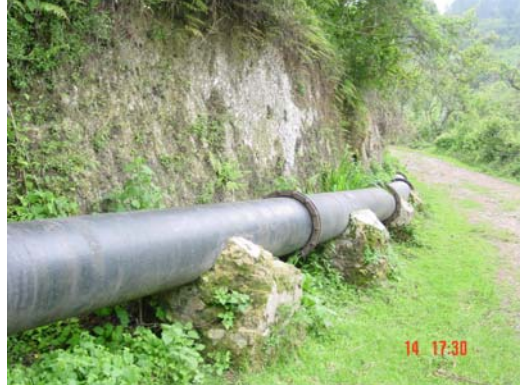
Figura 11. Tubería Teocinte II a Santa Luisa
