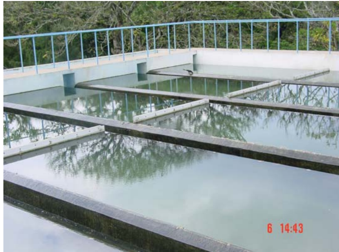
Figura 25. Sedimentadores
