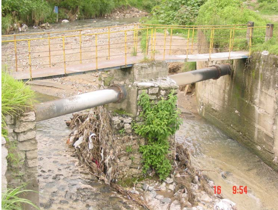
Figura 17. Paso aéreo km 0+550 hacia Santa Luisa, conducción Canalitos
