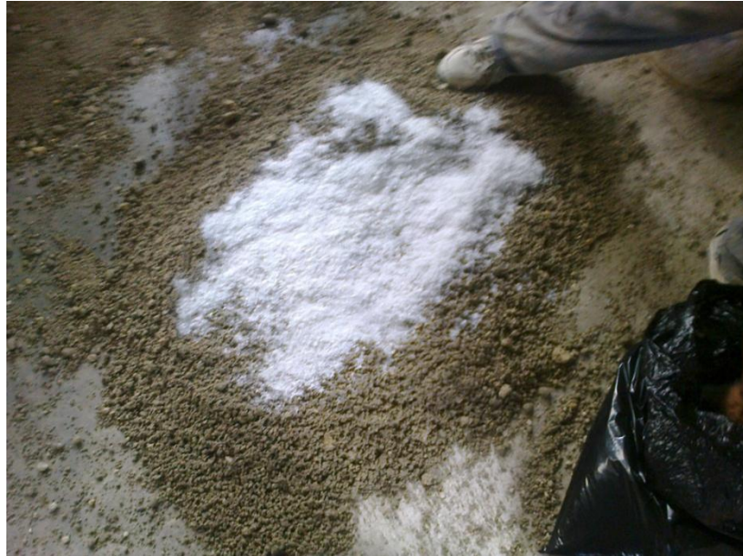
Figura 5. Mezcla de arena blanca, cemento y PET triturado
