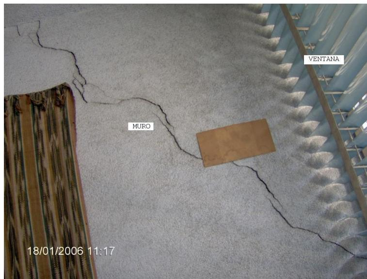
Figura 3. Defecto constructivo, la no linealidad del acero de refuerzo, perjudicando en la transmisión de cargas o el verdadero funcionamiento de los elementos estructurales que es distribuir uniformemente las cargas para efectivamente absorber y mantener en pie el elemento estructural.
