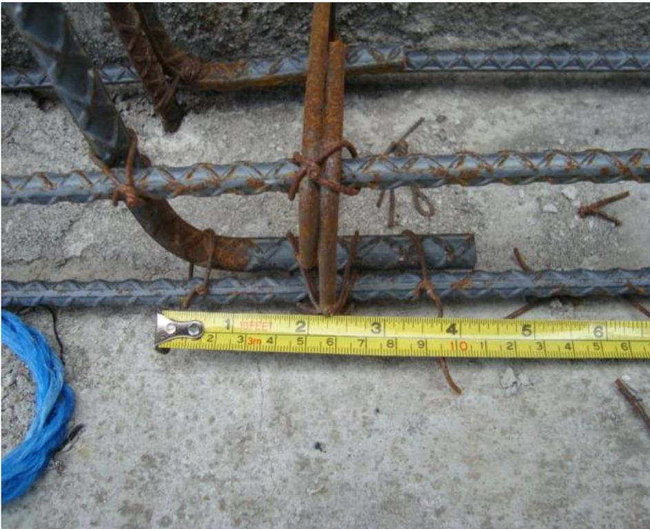
Figura 5. El no colocar una solera o viga uniendo los elementos estructurales como las columnas provoca debilitamiento en el sistema de la edificación, observándose como síntomas las fisuras o grietas en un futuro, tal como se puede apreciar en la siguiente fotografía.
