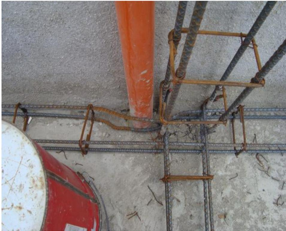
Figura 4. El desconocimiento de cómo interactúan las cargas en los empalmes o uniones entre elementos estructurales hace cometer este tipo de errores como el de no proporcionar la longitud adecuada del acero.
