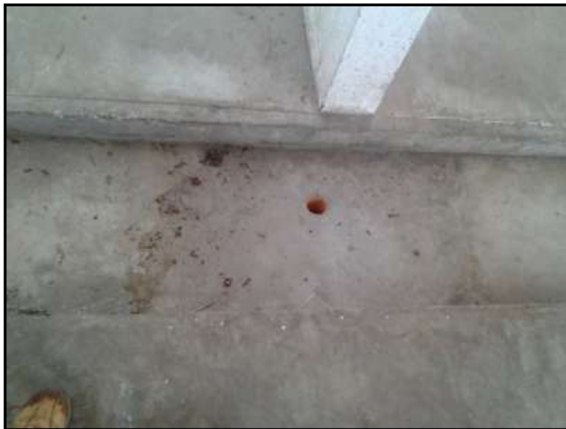
Figura 12. Situación actual de los pisos del área de cárnicos
