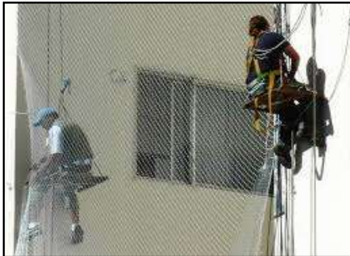
Figura 36. Instalación de áreas antiplagas
