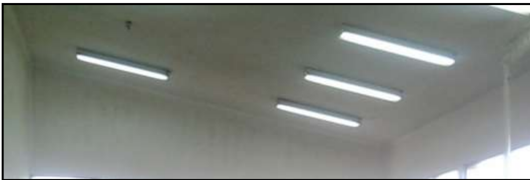
Figura 14. Situación actual del techo del área de cárnicos
