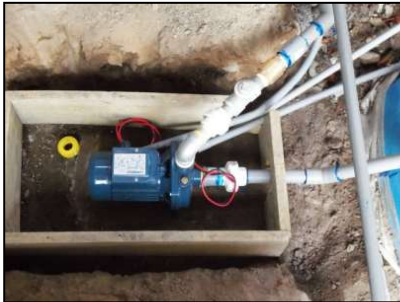
Figura 24. Bomba de abastecimiento de agua
