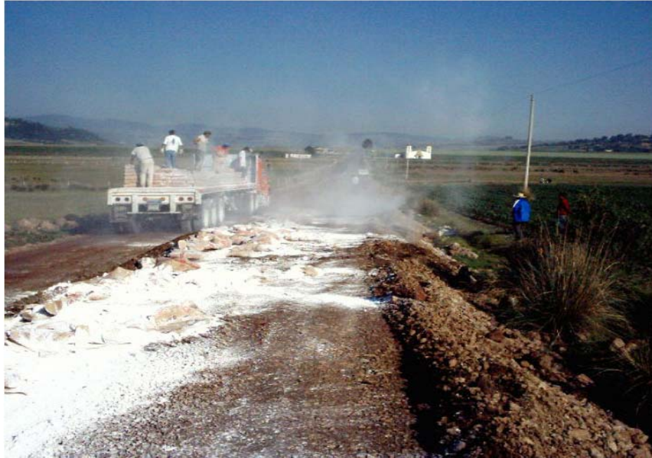
Figura 7. Aplicación directa de cal al suelo
