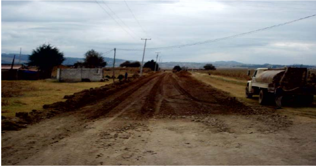
Figura 10. Aplicación de salmuera en campo
