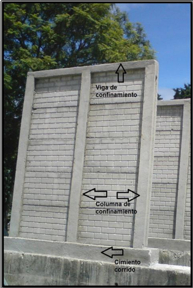
Figura 7. Muro de mampostería confinada, sistema placa-poste
