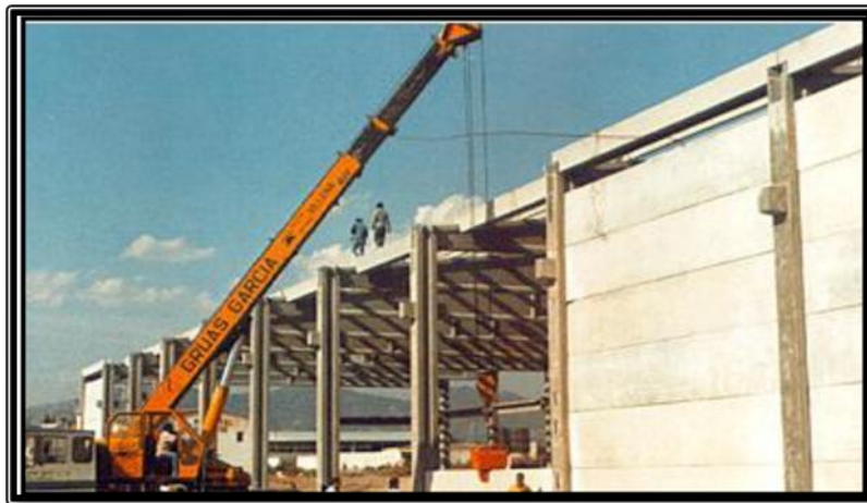
Figura 17. Montaje de elementos prefabricados, placas horizontales (para grandes luces)
