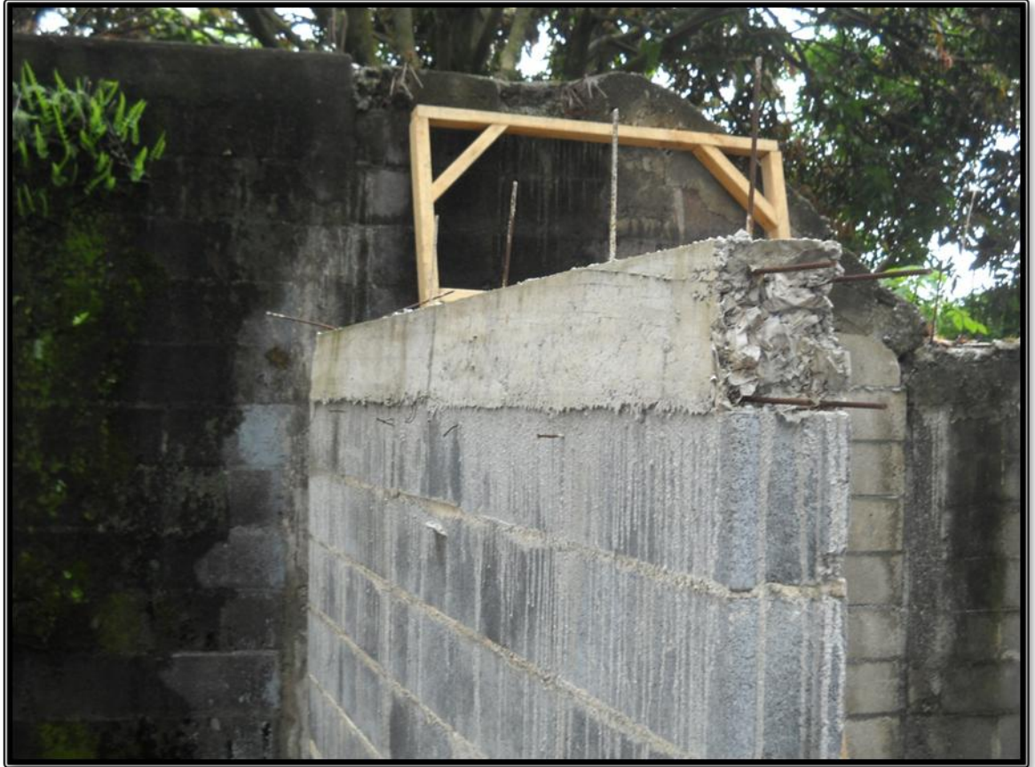
Figura 8. Muro de mampostería reforzada
