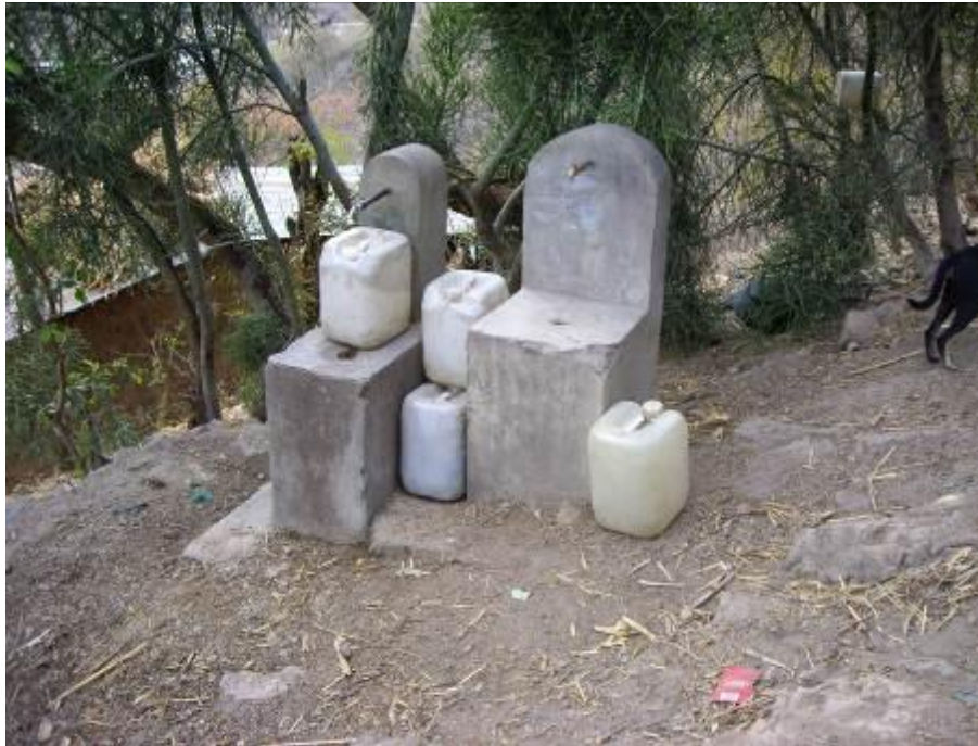
Figura 15. Sistema de agua potable por llena cántaros en la aldea Maraxcó
