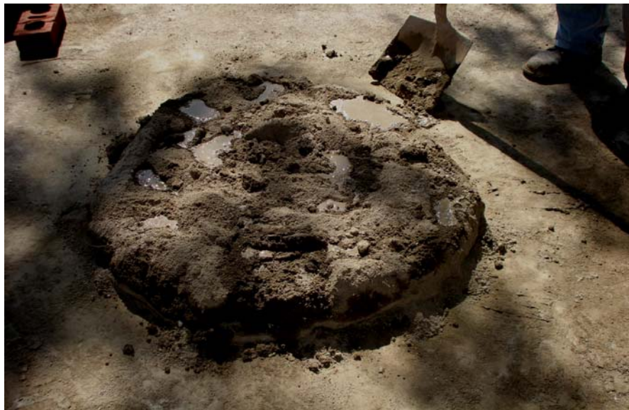
Figura 9. Elaboración de mortero de mampostería
