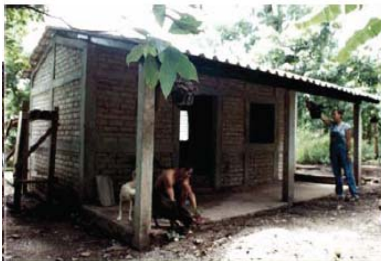
Figura 8. Construcción de mampostería sin recubrimiento en los muros
