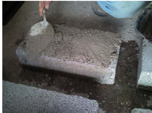
Figura 27. Ilustración adherencia aplicación de mezcla
