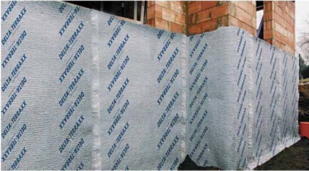
Figura 5. Colocación de DELTA-TERRAXX, se coloca igual que el sistema DELTA® NP DRAIN
