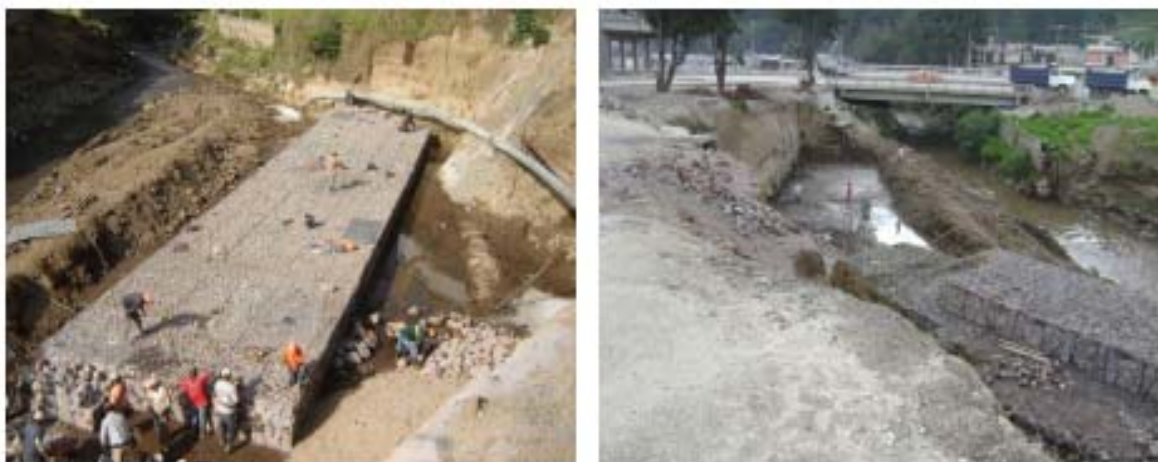
Figura 60. Armado de gaviones
