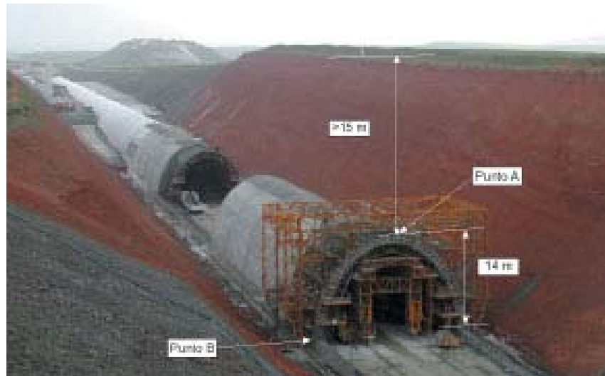
Figura 49. Falso Túnel
