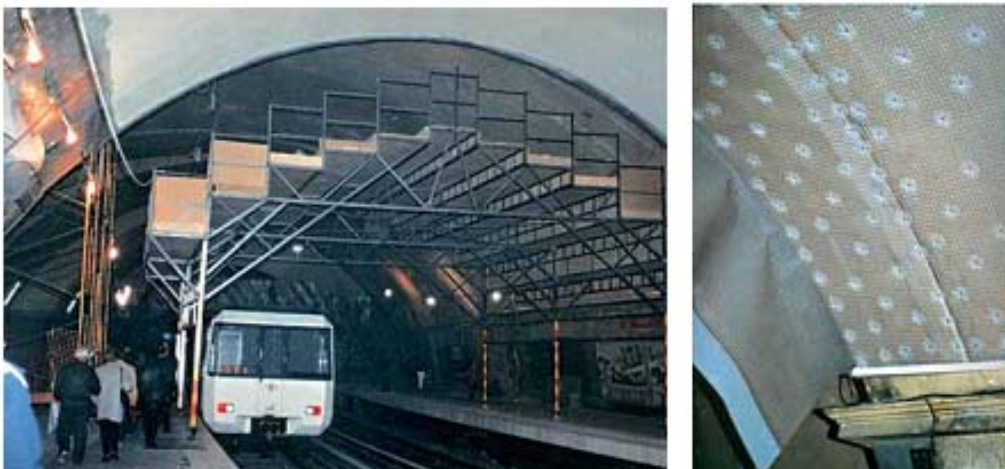
Figura 52. Colocación del sistema drenante en túnel
