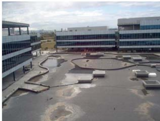
Figura 16. Centro de seis torres de edificios, Panamá.
