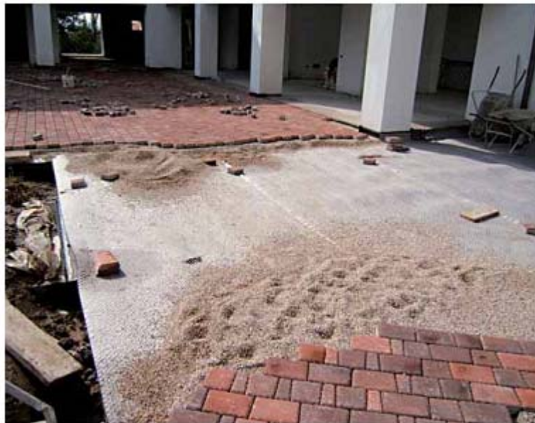
Figura 22. Colocación del sistema de drenaje horizontal bajo adoquinado
