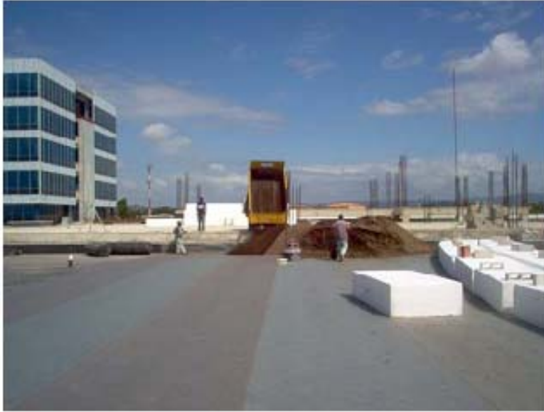
Figura 18. Colocación del material orgánico sobre el MacDrain 2L
