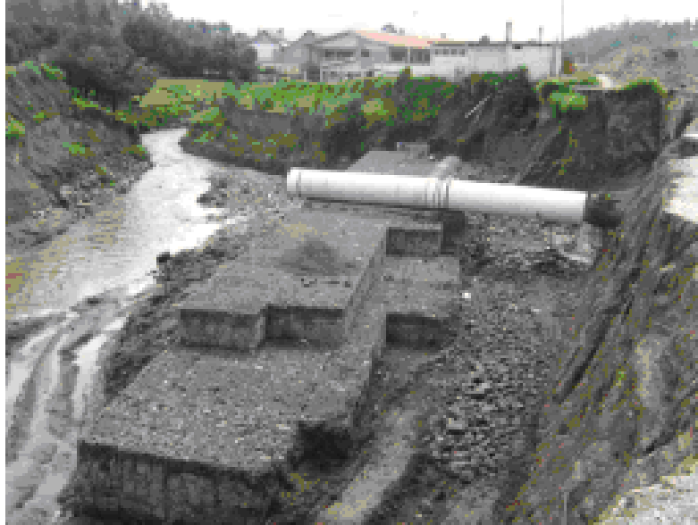
Figura 61. Adaptación del drenaje principal
