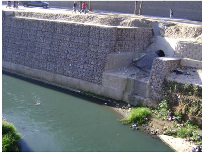
Figura 65. Vista de gaviones y Geotextil
