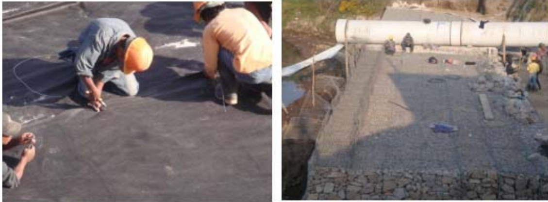
Figura 62. Colocación del sistema interno drenante, por medio de Geotextiles
