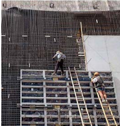
Figura 46. Colocación del sistema
