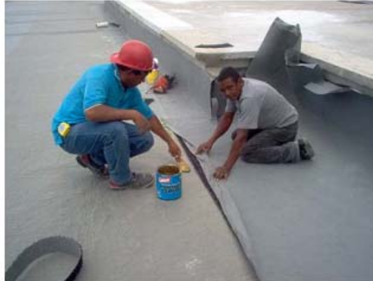
Figura 17. Colocación de la geomembrana, sobre la losa de concreto, para impermeabilizarla.
