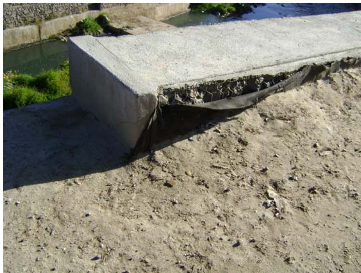
Figura 65. Vista de gaviones y Geotextil
