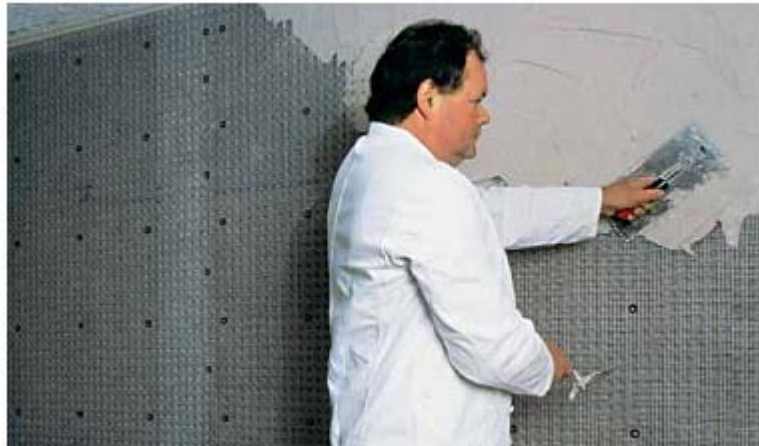
Figura 43. Colocación del sistema DELTA® PT
