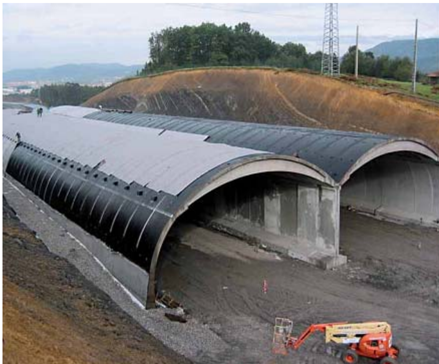
Figura 50. Colocación del Sistema drenante
