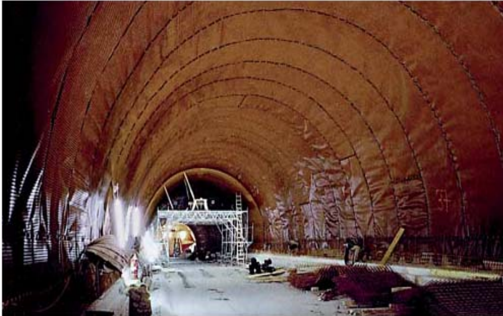
Figura 48. Colocación del sistema de drenaje
