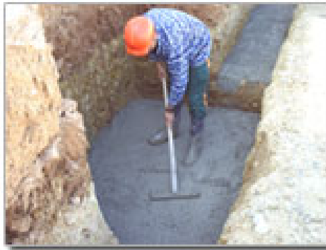
Sara urbana, Naves Industriales , memoria, Hormigón de limpieza.
