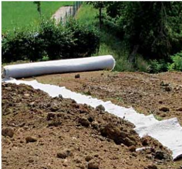
Figura 54. Colocación del sistema drenante
