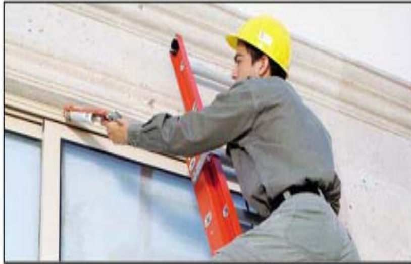
Figura 13 Instalación de ventanas de PVC
