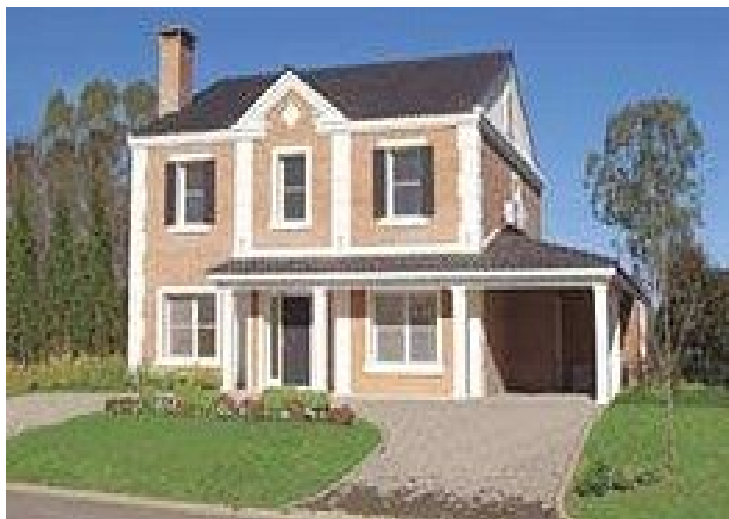
Figura 8 Puertas y ventanas de la vivienda residencial
