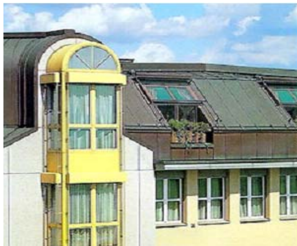
Figura 5 Detalles arquitectónicos de ventanas
