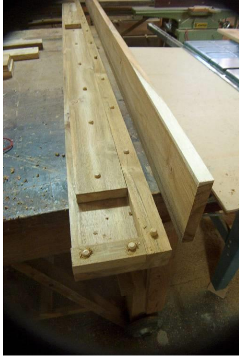
Aplicación de cola y colocación de tarugos
