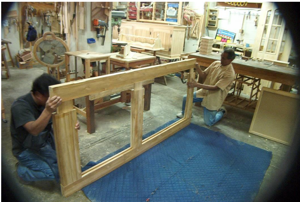
Se trabaja en equipo para facilitar el ensamble
