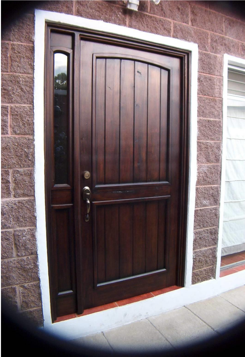
Vista puerta instalada
