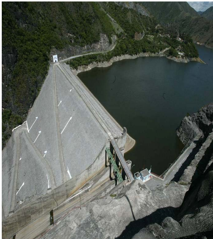
Figura 2. Embalse de simple propósito Pueblo Viejo Hidroeléctrica Chixoy
