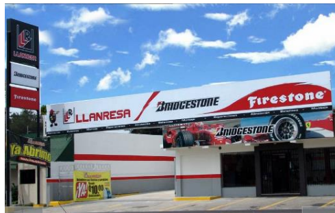
Figura 30. Centro de Servicio Puerta Parada
