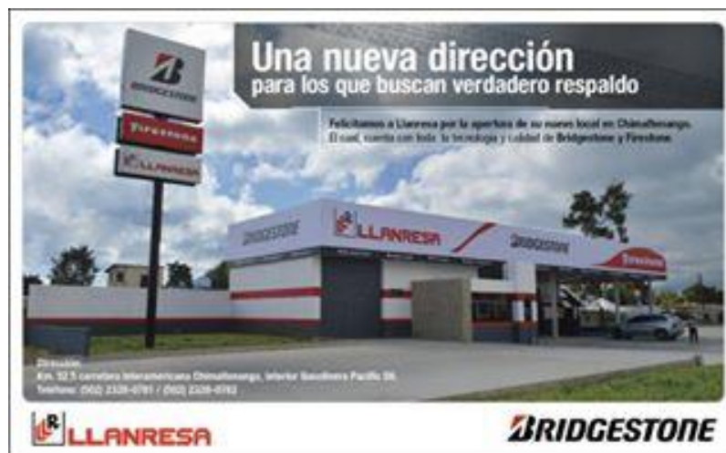
Figura 34. Centro de Servicio Chimaltenango
