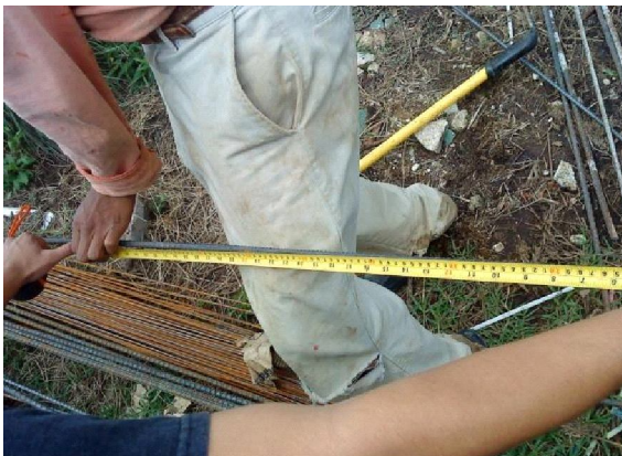
Figura 32. Medición de barras de acero para muestra en lugares de muestreo
