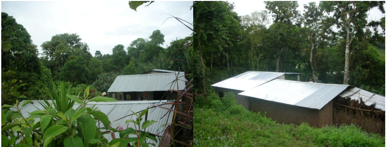
Figura 19. Techos de Viviendas, aldea La Mina
