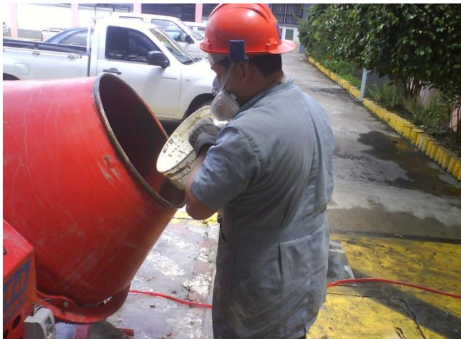
Figura 10: Mezclado de los materiales en la concretera
