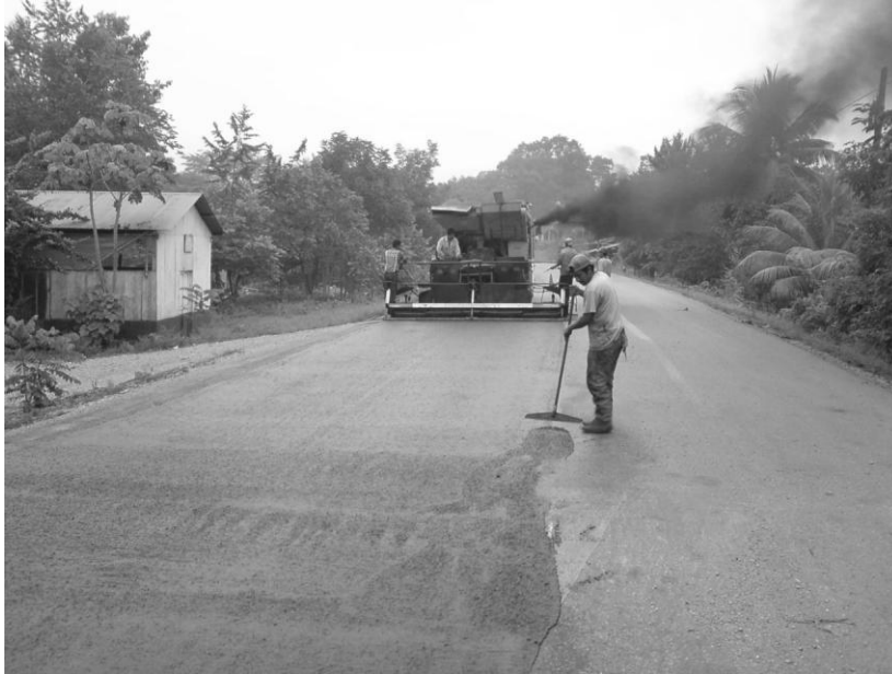
Figura 17. Reparación de junta longitudinal
