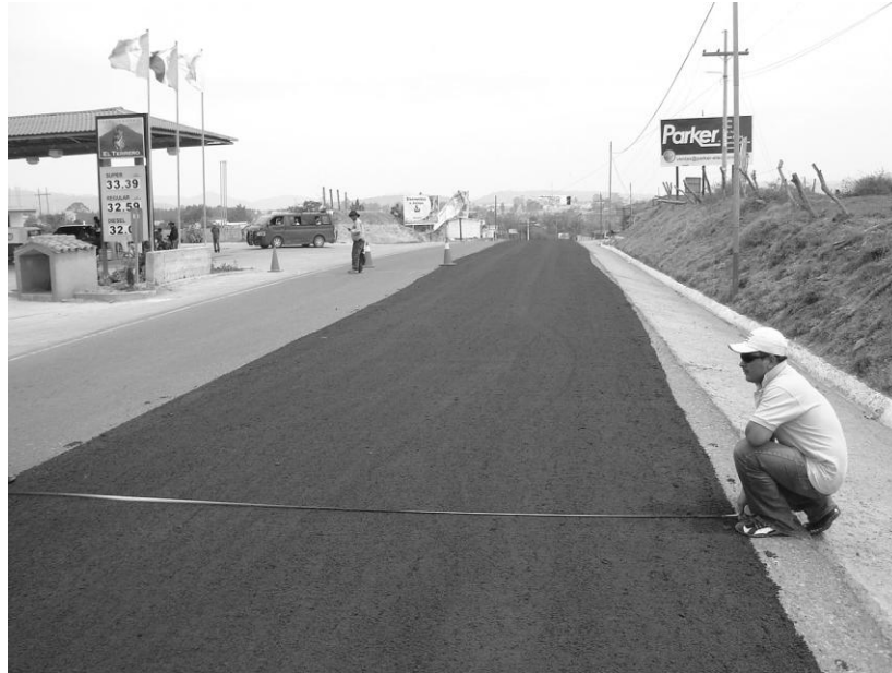
Figura 18. Medición de ancho de carpeta aplicada
