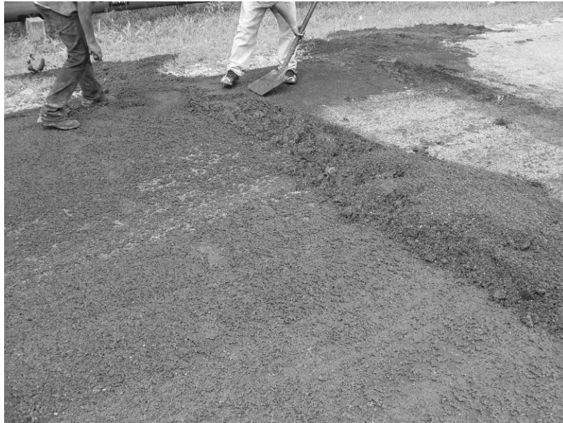
Figura 11. Limpieza y preparación de la junta transversal a tope
