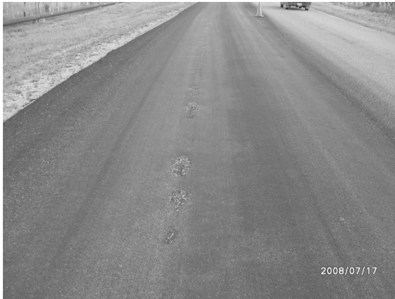
Figura 15. Reparación de la carpeta por medio de baches
