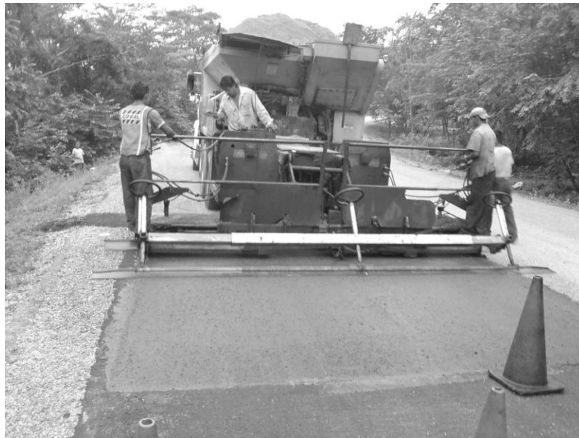
Figura 13. Junta transversal a tope terminada
