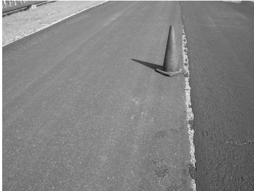
Figura 16. Reparación por medio de bache en junta longitudinal
