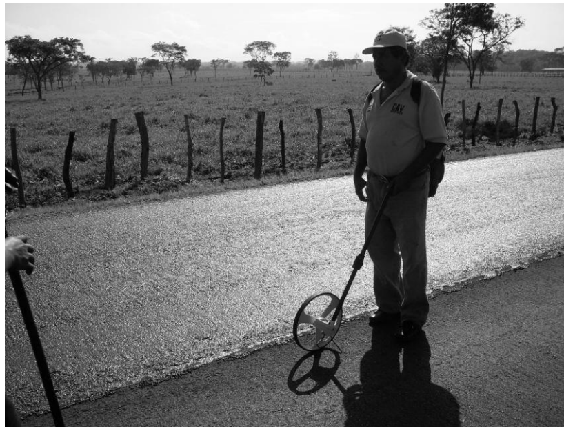
Figura 19. Medición de la longitud de carpeta aplicada
