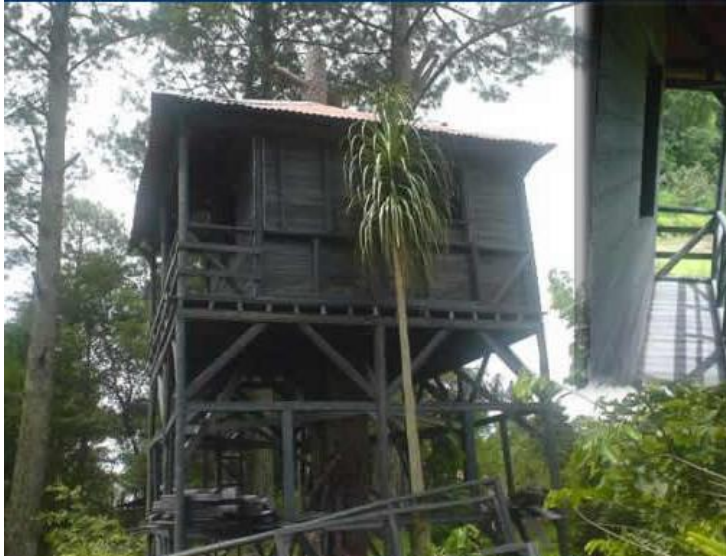
Figura 9. Rancho fabricado de madera plástica
