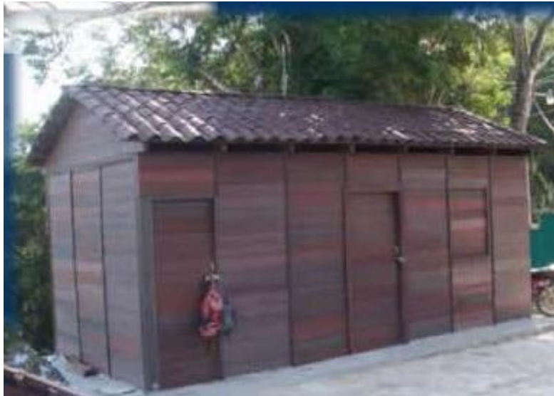
Figura 10. Casa fabricada de madera plástica
