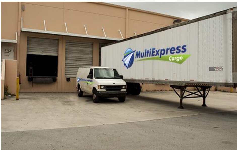
Figura 8. Bahías de descarga
