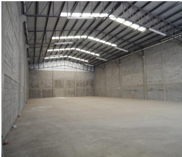
Figura 7. Paredes de la nave industrial
