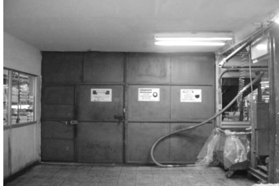
Figura 5. Vista frontal portón de ingreso área de peletización
