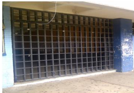
Figura 68. Salida de emergencia edificios S2, S5 y S7
