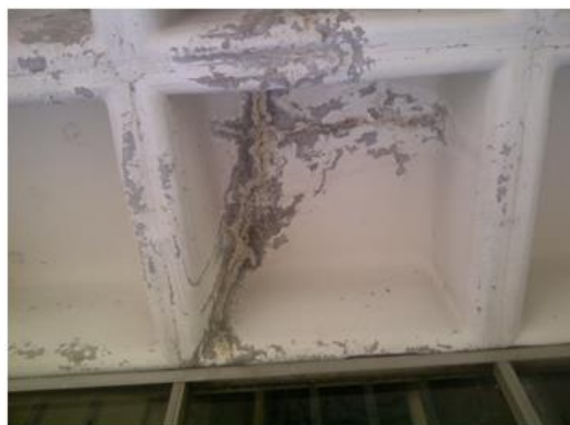
Figura 47. Filtración de líquidos
