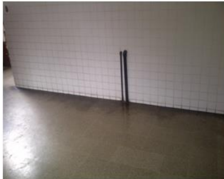
Figura 30. Tubería expuesta
