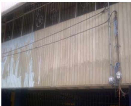
Figura 50. Cables eléctricos expuestos
