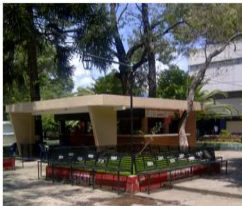
Figura 48. Cafetería con cilindro de gas propano
