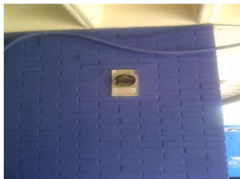
Figura 50. Cables eléctricos expuestos
