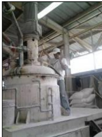
Figura 5. Raspado de limpieza en mezclador de corta grasa.
