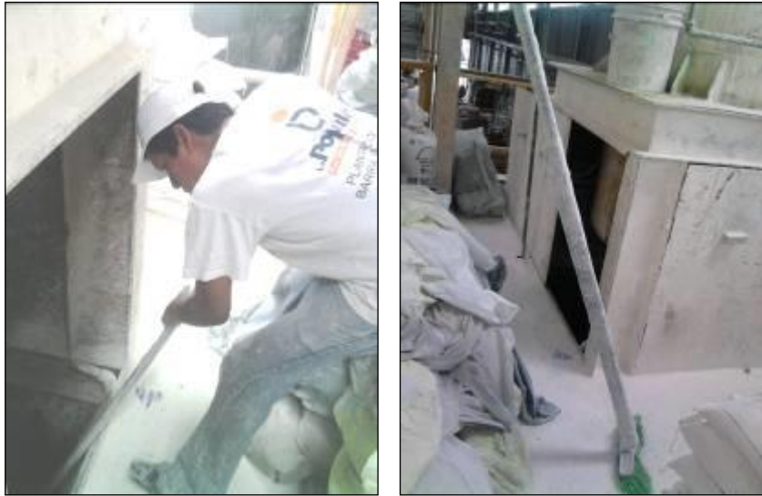
Figura 6. Limpieza de tolva de línea de corta grasa
