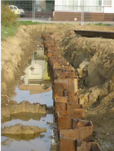
Figura 21. Uso de tablestacas para la contención de suelo
