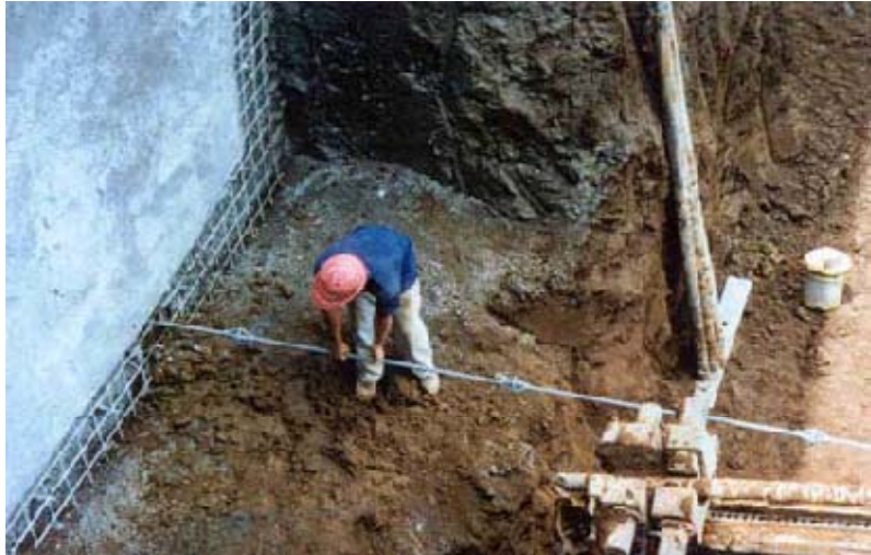
Figura 10. Colocación de acero de refuerzo
