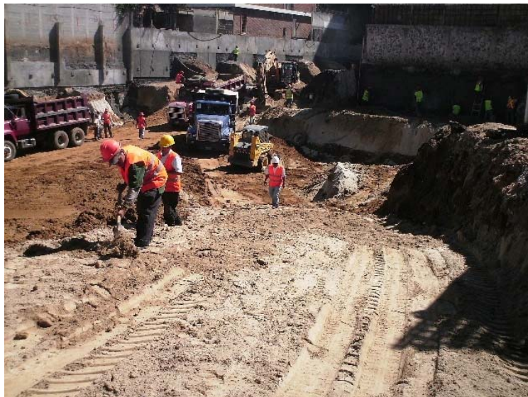
Figura 34. Colocación de material no plástico (polvillo) en rampa
