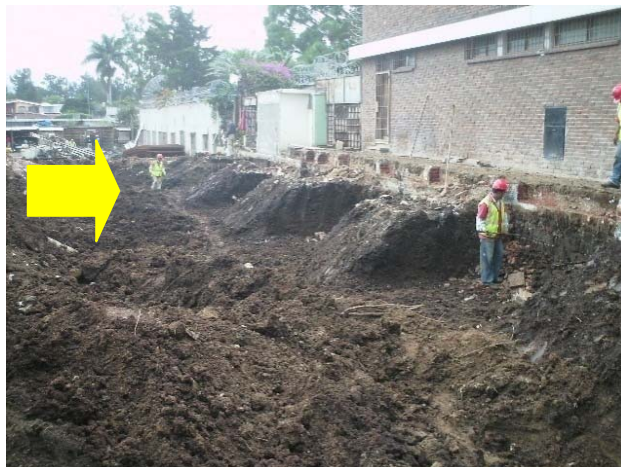
Figura 32. Bermas luego de realizar la excavación
