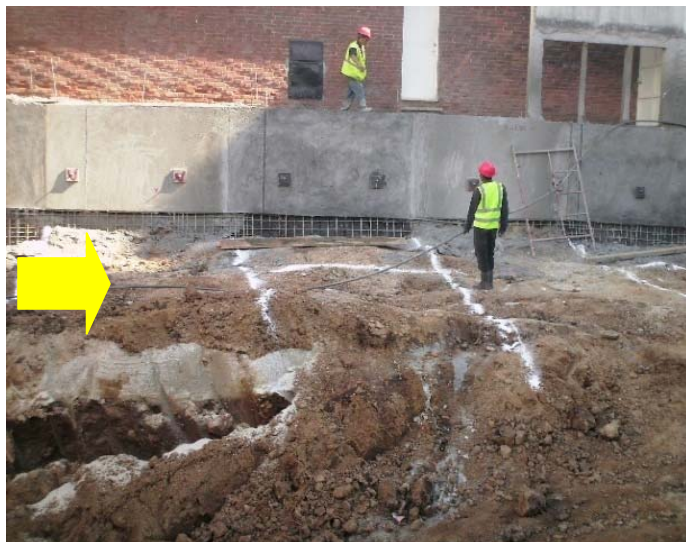
Figura 32. Bermas luego de realizar la excavación
