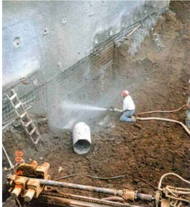
Figura 12. Proceso de lanzado
