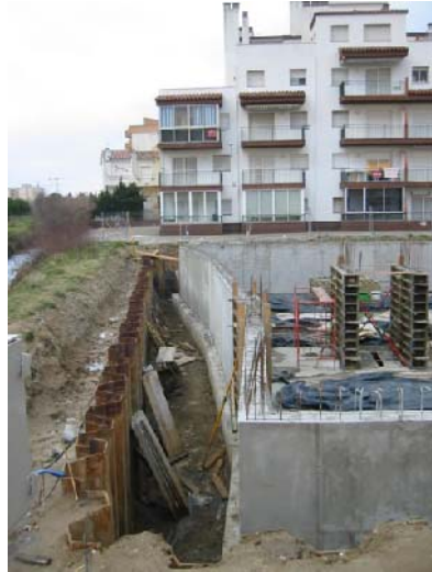
Figura 21. Uso de tablestacas para la contención de suelo
