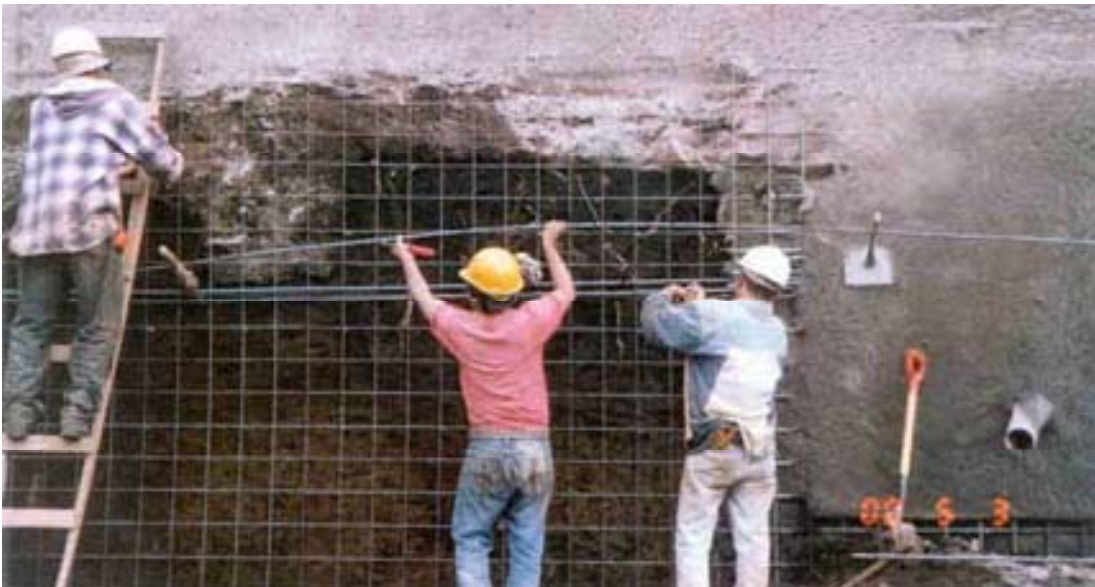
Figura 11. Colocación de refuerzo longitudinal
