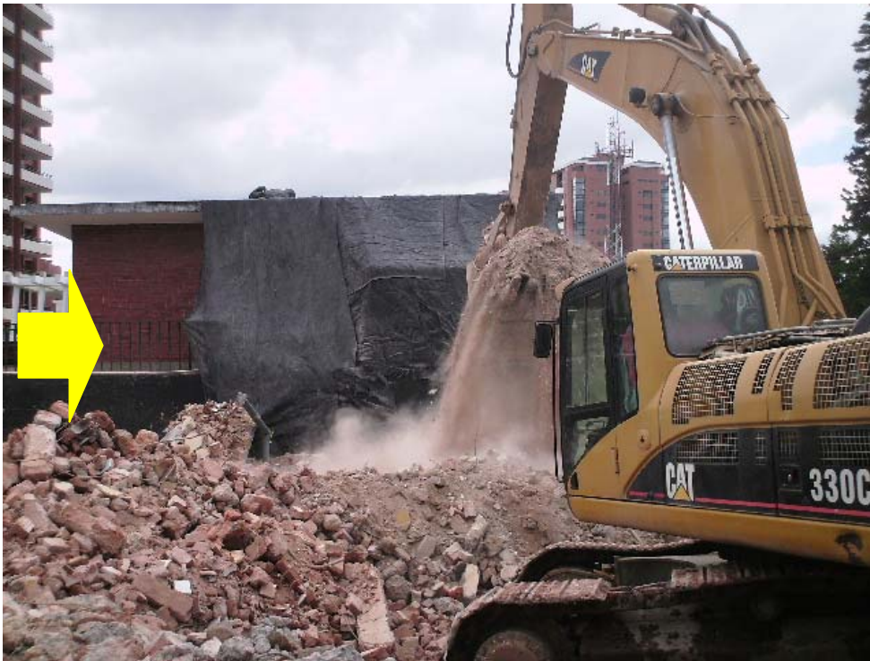
Figura 28. Protección de edificación aledaña con plástico
