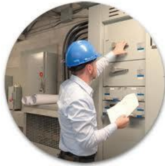
Figura 35. Inspección de sistemas
