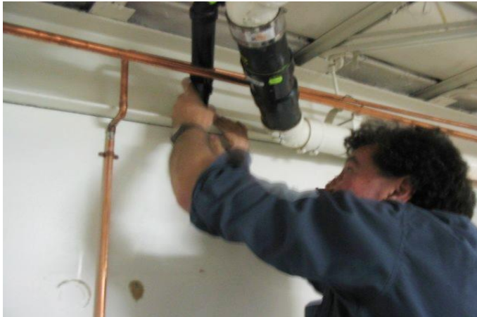
Figura 36. Inspección del sistema de aguas pluviales
