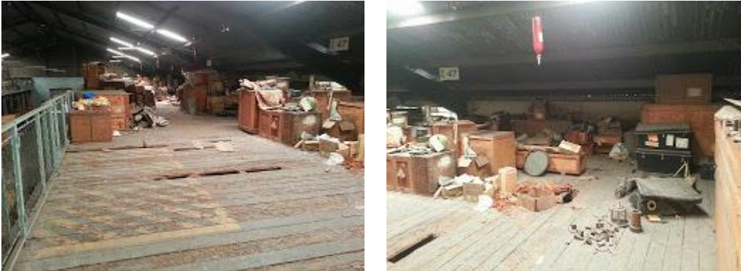
Figura 14. Reparación de entrepisos
