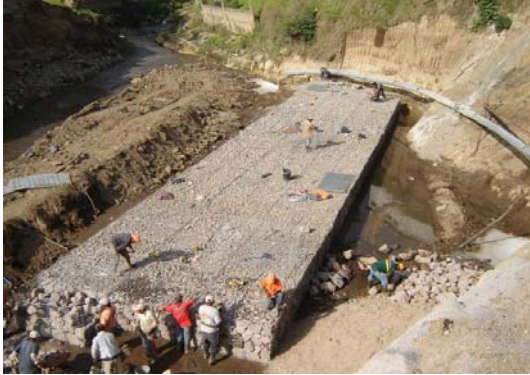
Armado del colchón reno.
