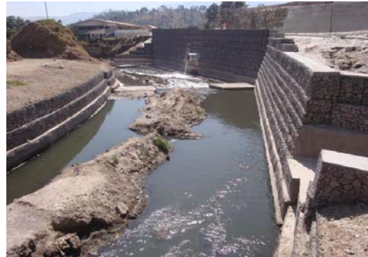
Tierra armada para carril auxiliar.
