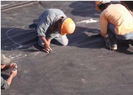
Instalación de filtro geotextil.
