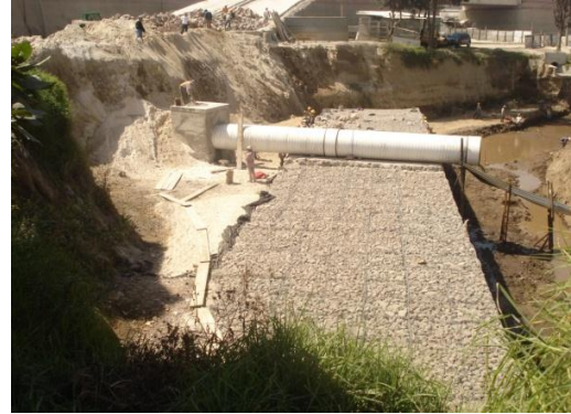
Conducción de drenaje existente.
