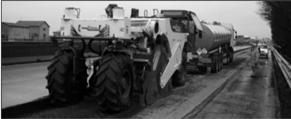
Figura 18. Recicladora Wirtgen WR2000, montada sobre neumáticos
