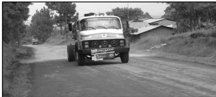
Figura 36. Humectación de la pista estabilizada con asfalto
