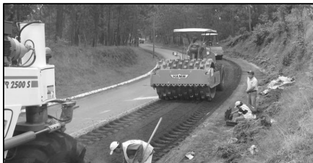
Figura 35. Compactación del material reciclado y estabilizado
