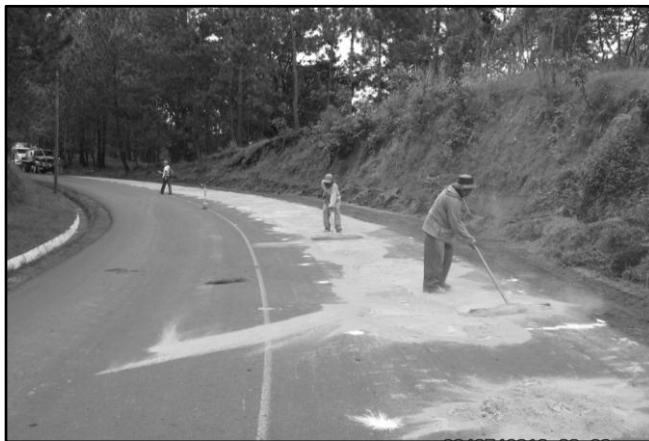
Figura 32. Preparación de la pista para iniciar el reciclado
