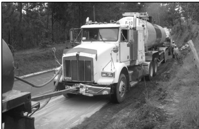
Figura 33. Configuración del tren de reciclado
