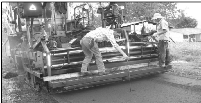
Figura 37. Colocación de la carpeta de rodadura asfáltica
