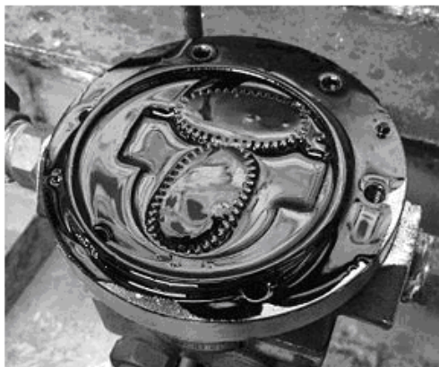
Figura 8. Interior de un equipo
