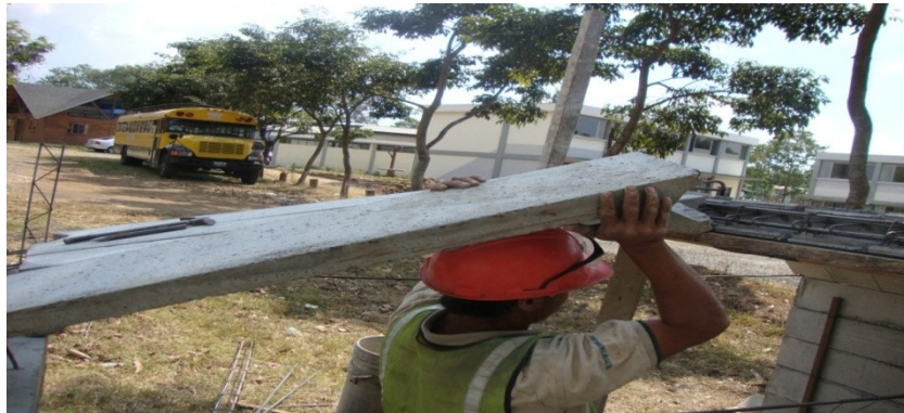
Figura 28. Colocación de placas de la segunda parte
