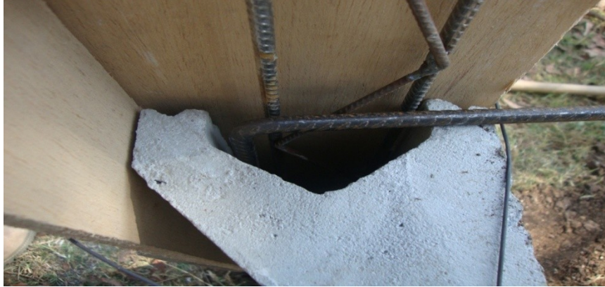
Figura 23. Formaleta del extremo del muro
