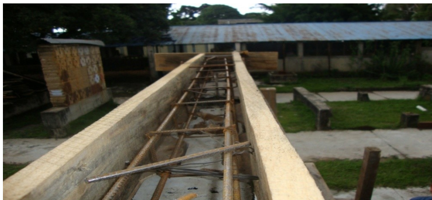
Figura 16. Colocación de formaleta para solera corona
