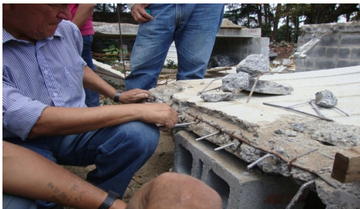
Figura 61. Unión de ambas losas
