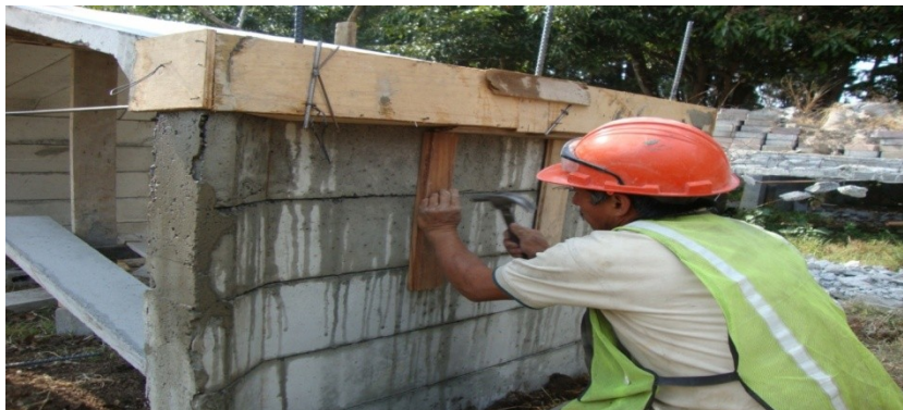
Figura 30. Colocación de formaleta en los extremos
