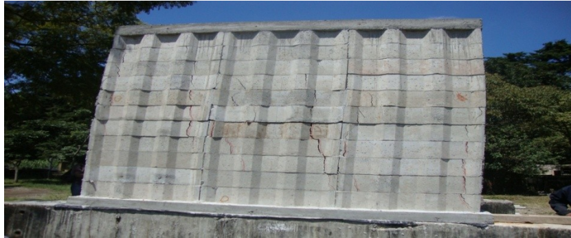
Figura 40. Muro tipo llave sin refuerzo ensayado
