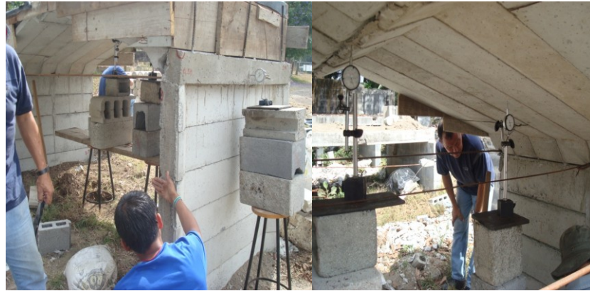
Figura 48. Colocación de deformómetros
