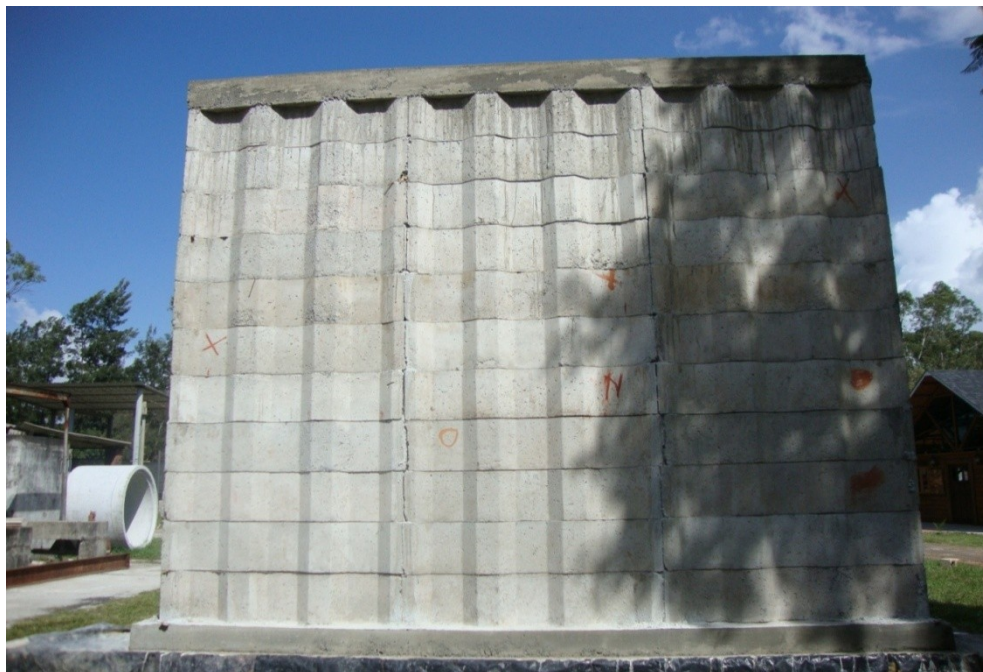
Figura 18. Muro tipo llave sin refuerzo terminado
