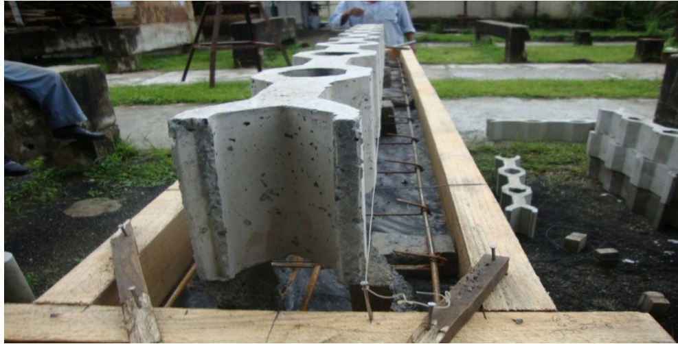
Figura 6. Primera hilada colocada
