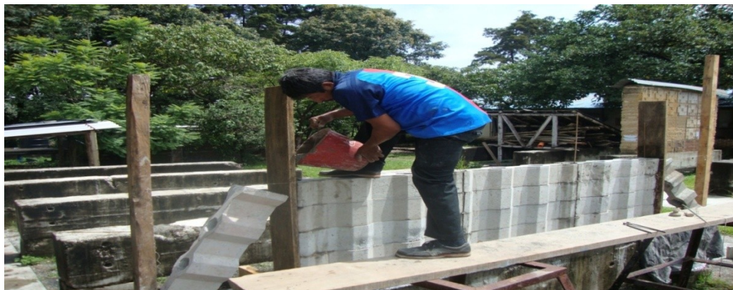
Figura 13. Fundición de pines de los extremos
