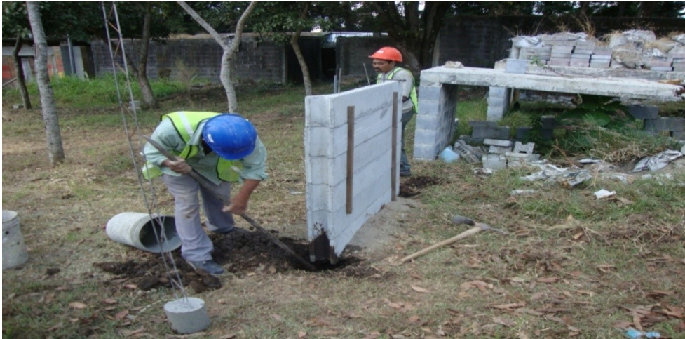
Figura 20. Inicio de montaje de muro tipo llave reforzado
