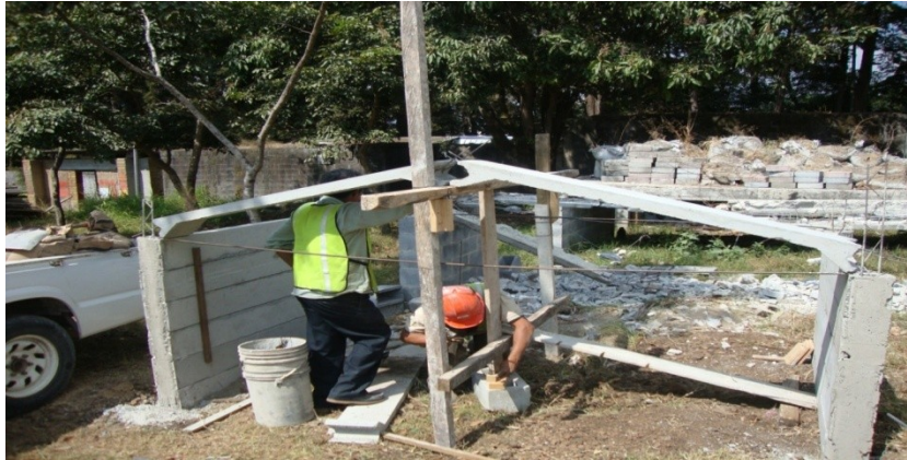
Figura 26. Montaje de losa
