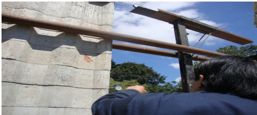
Figura 37. Colocación de deformómetros
