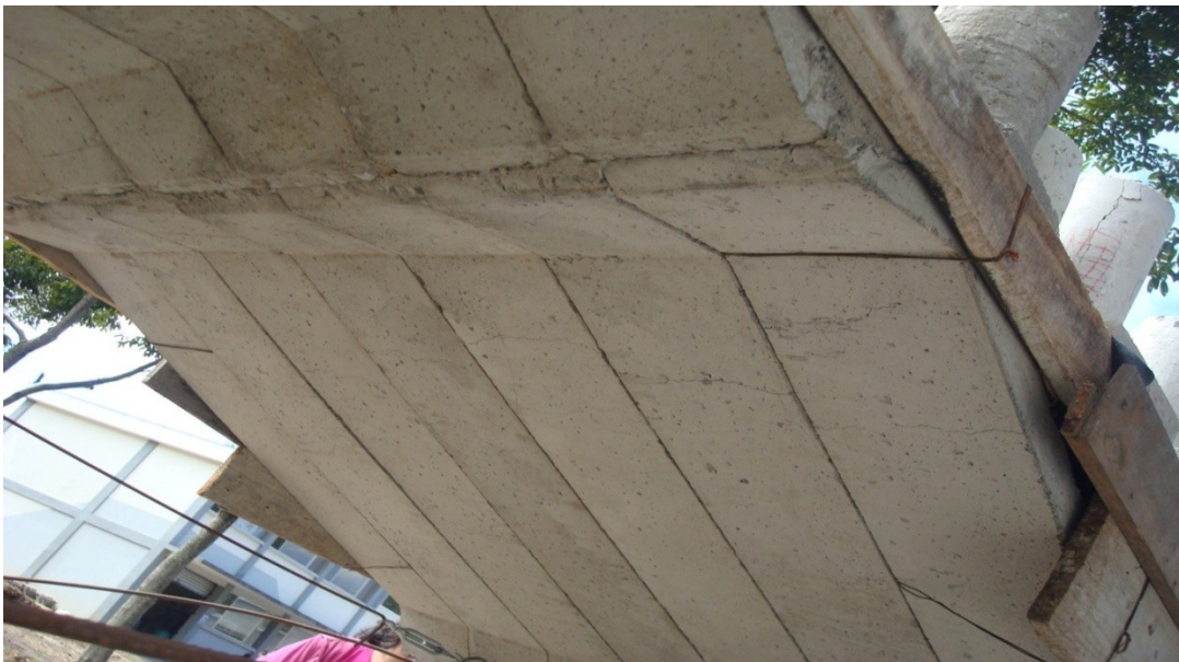
Figura 53. Losa fisurada
