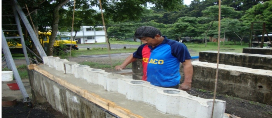
Figura 9. Fundición de pines intermedios
