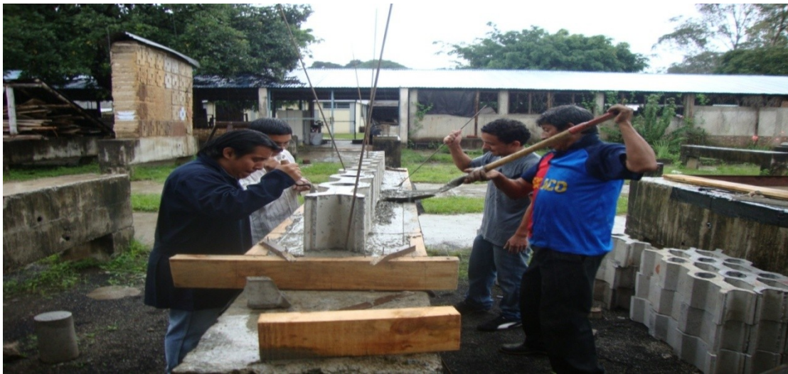
Figura 8. Fundición de cimiento
