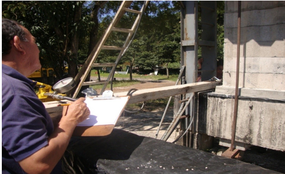
Figura 38. Toma de lecturas del deformometro
