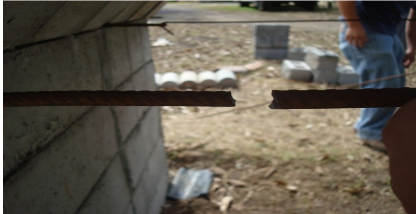
Figura 51. Corte de varilla de tensor
