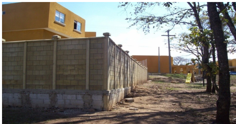
Figura 2. Barda típica de placa y poste
