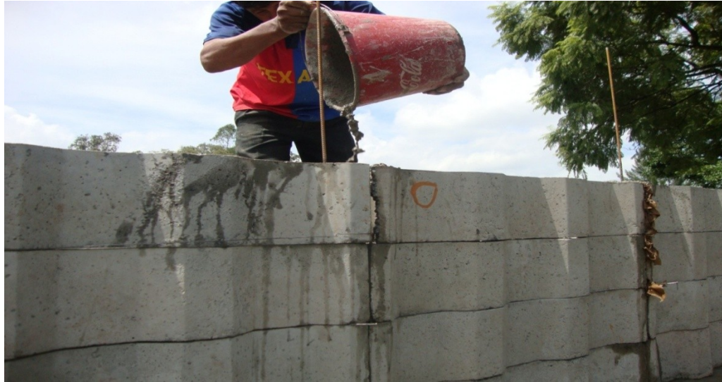
Figura 12. Fundición de quinta hilada
