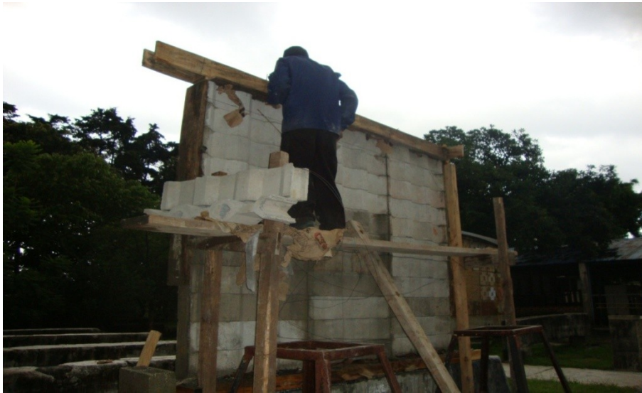
Figura 17. Fundición de solera corona
