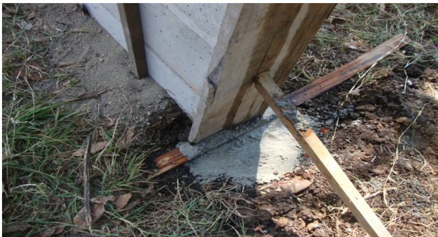
Figura 24. Fundición de costilla y la base del pin
