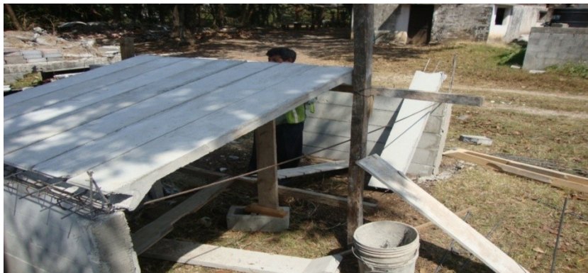
Figura 27. Colocación de primera parte de la losa
