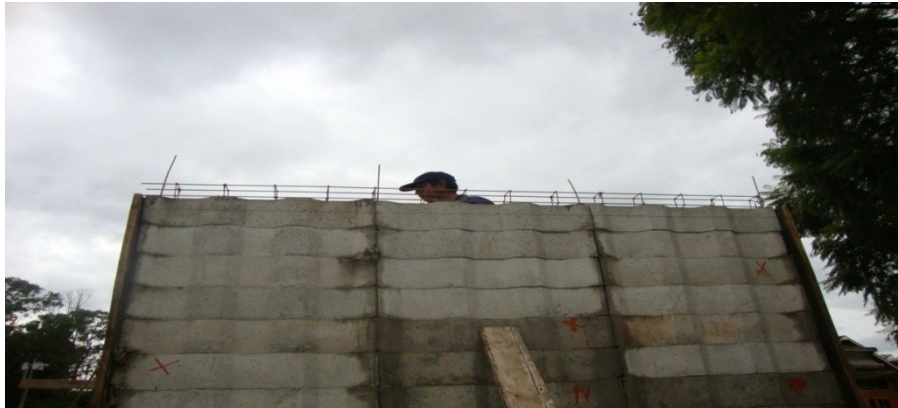
Figura 15. Colocación de la armadura de la solera corona en la hilada número 11
