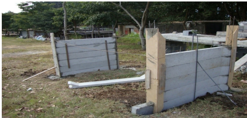
Figura 25. Armado de los dos muros
