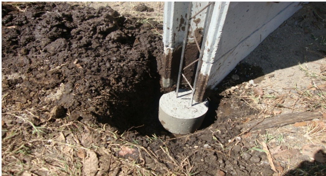
Figura 22. Colocación de pin en el suelo
