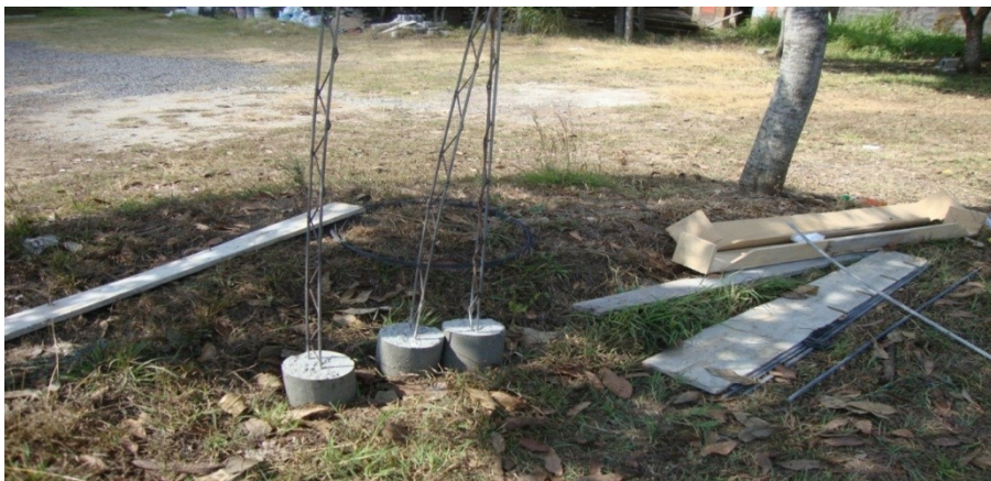
Figura 21. Costillas formadas con 2 varillas con base fundida
