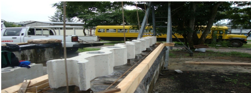
Figura 7. Colocación de pines de refuerzo
