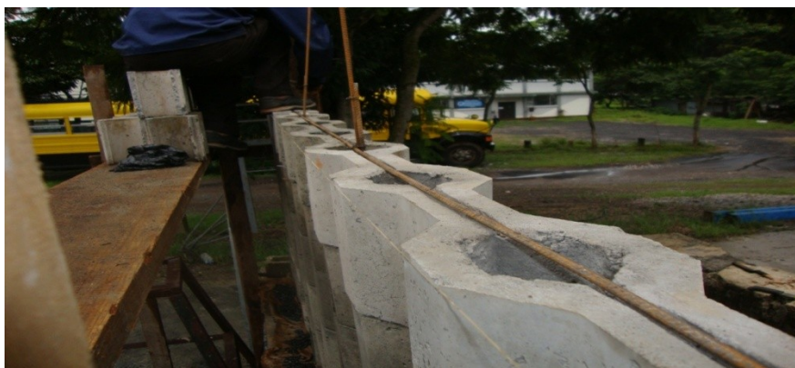
Figura 10. Colocación del refuerzo horizontal
