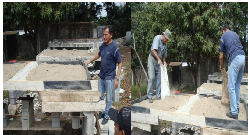
Figura 49. Colocación de arena para nivelar el área
