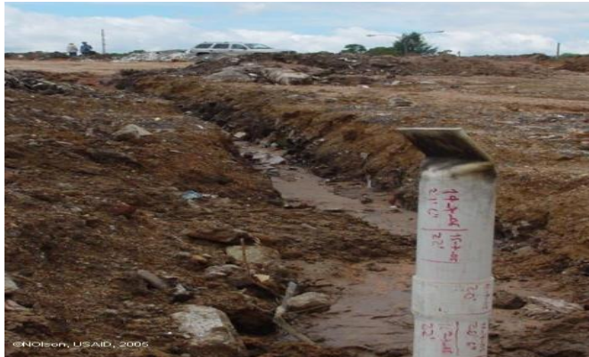
Figura 1. Preparando el terreno para medir la cantidad y calidad del gas metano que genera el relleno
