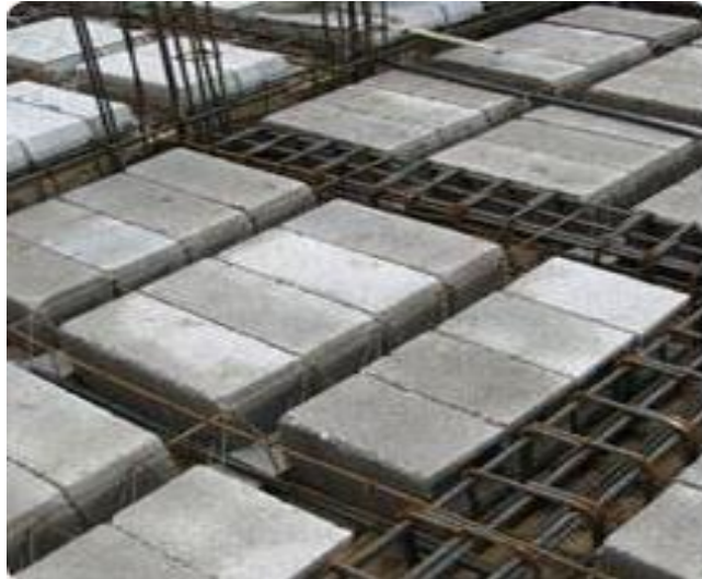
Figura 18. Ejemplo del sistema vigueta y bovedilla
