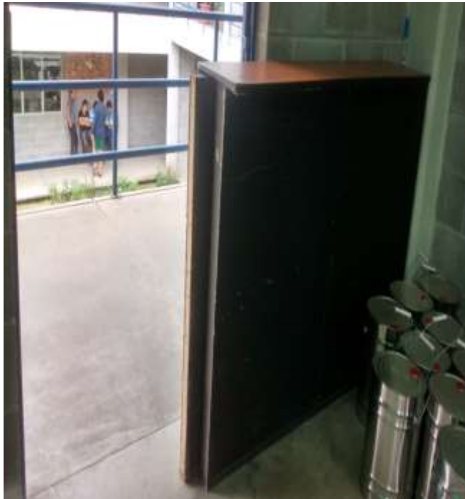
Figura 8. Puerta de acceso al almacén
