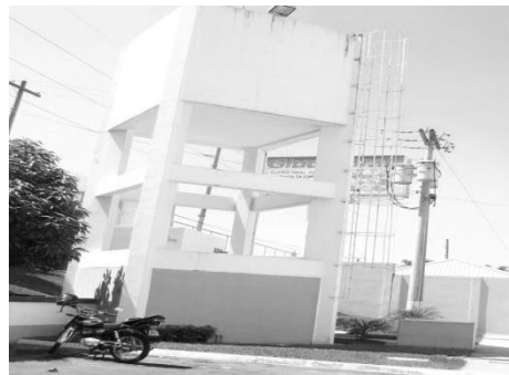
Figura 26. Cisterna que recibe el agua del pozo
