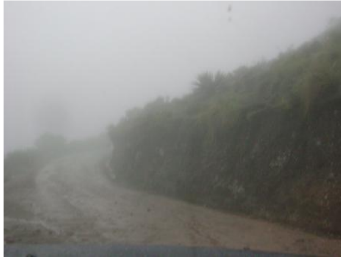
Figura 72. Tramo: San José Ojetenam a Concepción Tutuapa, estación 13+000
