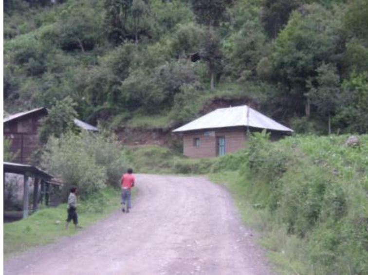
Figura 48. Tramo: Tacaná a San José Ojetenam, estación 4+000
