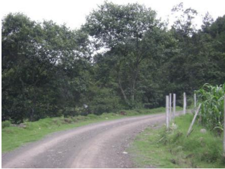
Figura 52. Tramo: Tacaná a San José Ojetenam, estación 8+000
