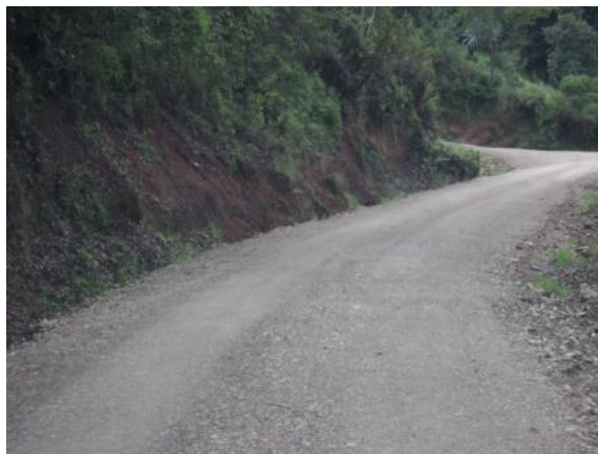
Figura 89. Tramo: Concepción Tutuapa a San Miguel Ixtahuacán, estación 8+000
