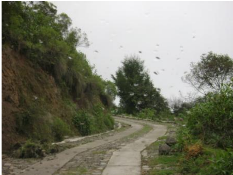
Figura 55. Tramo: Tacaná a San José Ojetenam, estación 11+000
