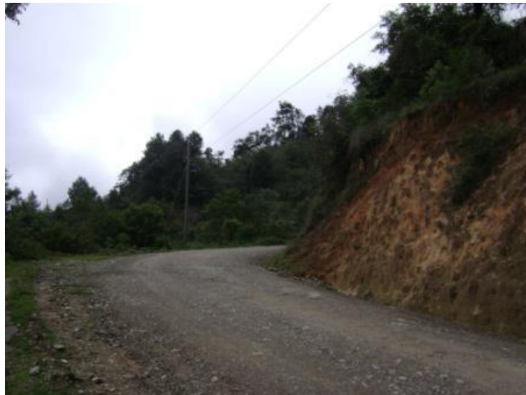
Figura 21. Tramo: Tacaná a frontera con México, estación 3+000
