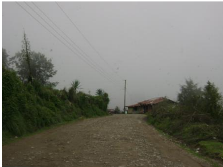
Figura 25. Tramo: Tacaná a frontera con México, estación 7+000
