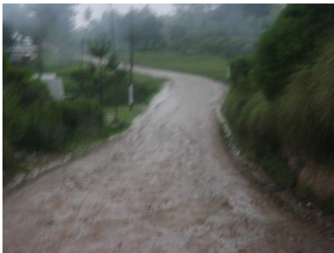
Figura 79. Tramo: San José Ojetenam a Concepción Tutuapa, estación 20+000
