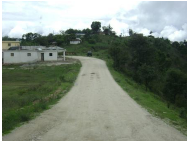
Figura 39. Tramo: Tacaná a frontera con México, estación 21+000
