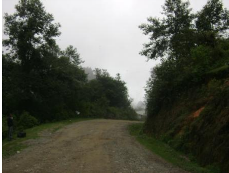
Figura 30. Tramo: Tacaná a frontera con México, estación 12+000
