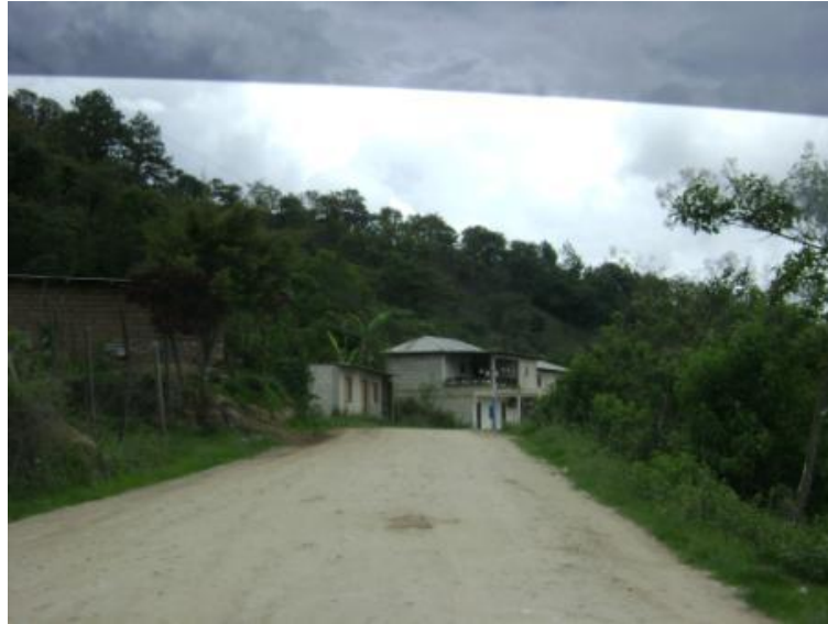
Figura 42. Tramo: Tacaná a frontera con México, estación 24+000
