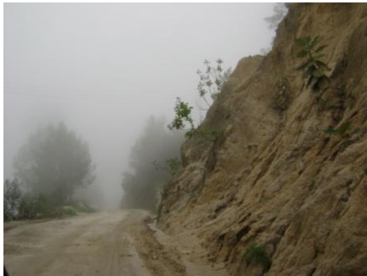
Figura 35. Tramo: Tacaná a frontera con México, estación 17+000
