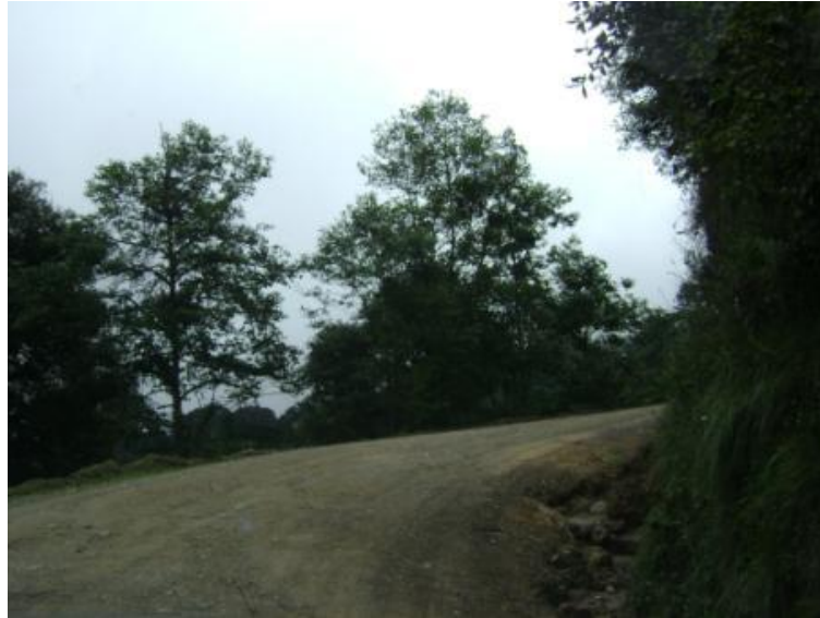
Figura 22. Tramo: Tacaná a frontera con México, estación 4+000
