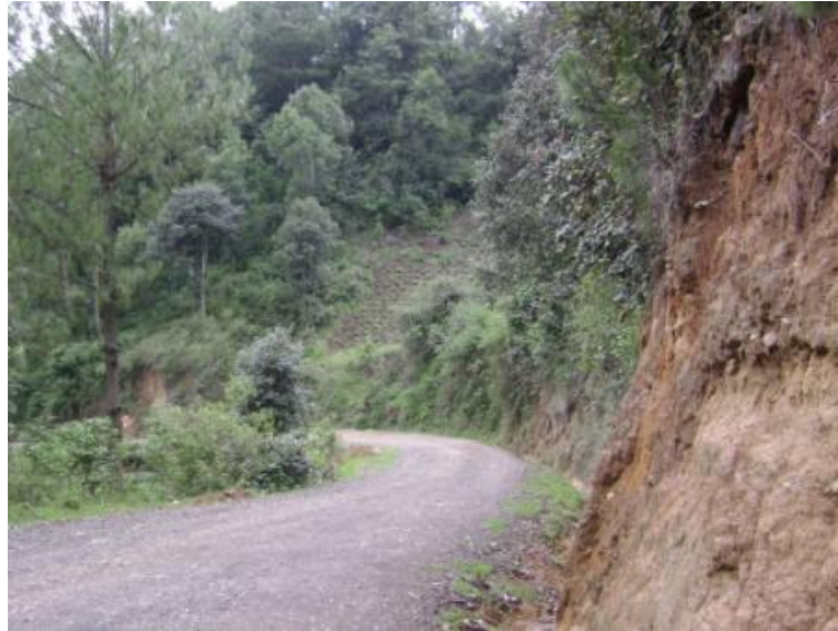
Figura 46. Tramo: Tacaná a San José Ojetenam, estación 2+000
