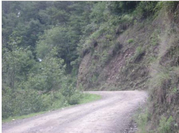
Figura 49. Tramo: Tacaná a San José Ojetenam, estación 5+000
