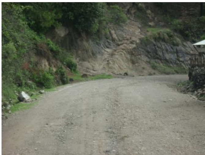
Figura 83. Tramo: Concepción Tutuapa a San Miguel Ixtahuacán, estación 2+000
