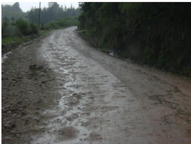
Figura 75. Tramo: San José Ojetenam a Concepción Tutuapa, estación 16+000
