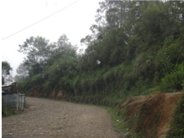
Figura 28. Tramo: Tacaná a frontera con México, estación 10+000
