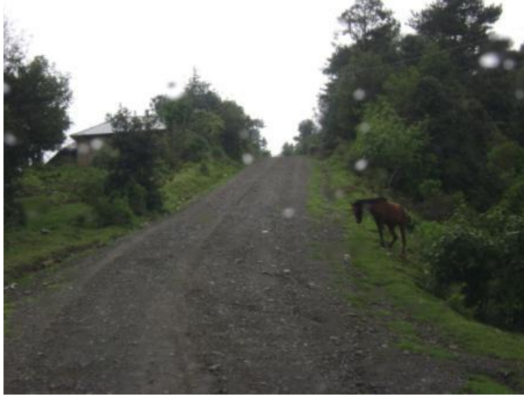
Figura 54. Tramo: Tacaná a San José Ojetenam, estación 10+000
