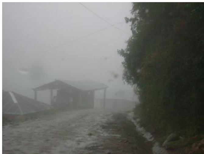
Figura 73. Tramo: San José Ojetenam a Concepción Tutuapa, estación 14+000
