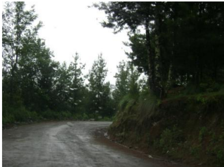
Figura 57. Tramo: Tacaná a San José Ojetenam, estación 13+000
