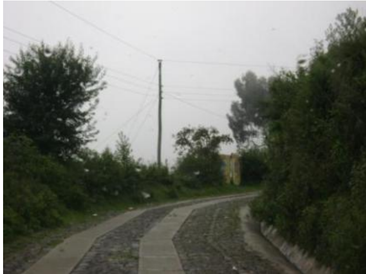
Figura 58. Tramo: Tacaná a San José Ojetenam, estación 14+000
