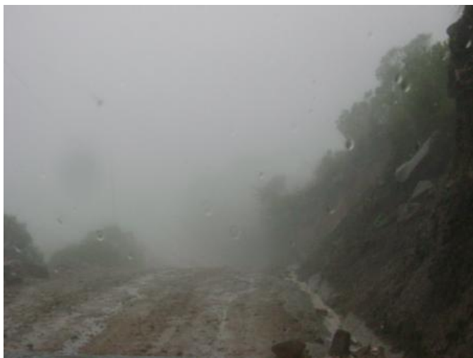
Figura 71. Tramo: San José Ojetenam a Concepción Tutuapa, estación 12+000
