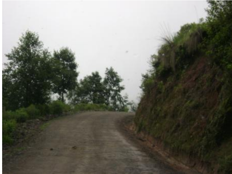
Figura 56. Tramo: Tacaná a San José Ojetenam, estación 12+000
