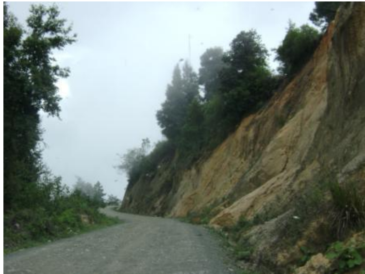
Figura 31. Tramo: Tacaná a frontera con México, estación 13+000
