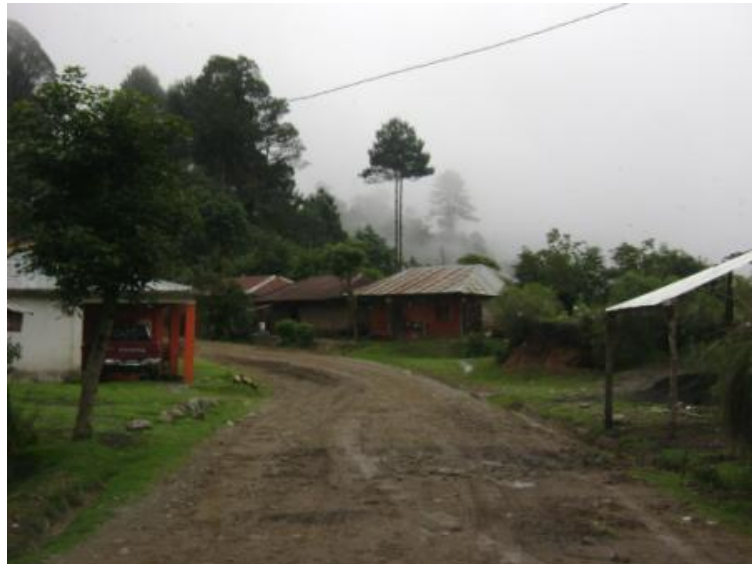
Figura 27. Tramo: Tacaná a frontera con México, estación 9+000
