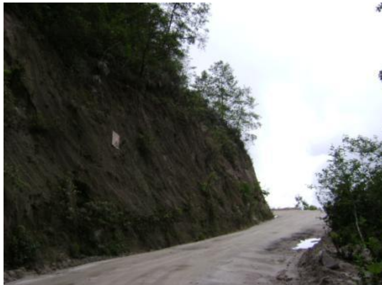
Figura 33. Tramo: Tacaná a frontera con México, estación 15+000
