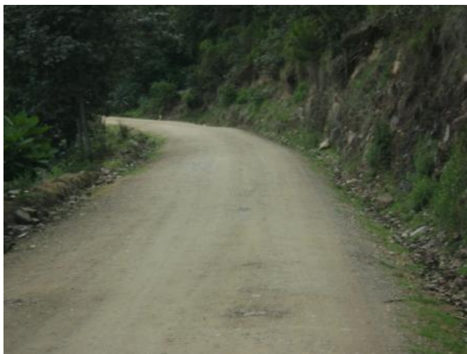
Figura 91. Tramo: Concepción Tutuapa a San Miguel Ixtahuacán, estación 10+000
