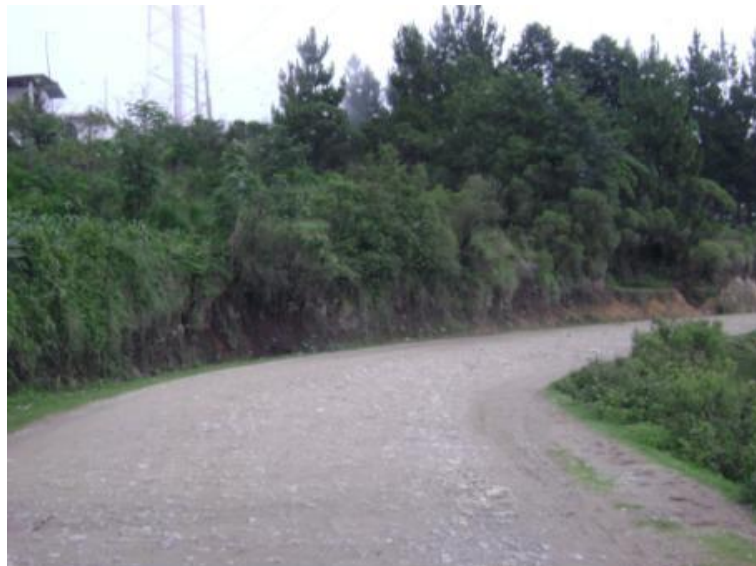
Figura 29. Tramo: Tacaná a frontera con México, estación 11+000
