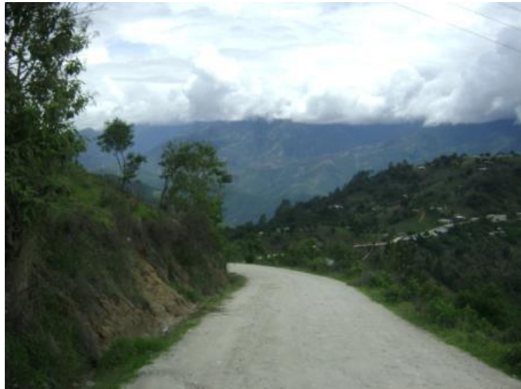
Figura 41. Tramo: Tacaná a frontera con México, estación 23+000
