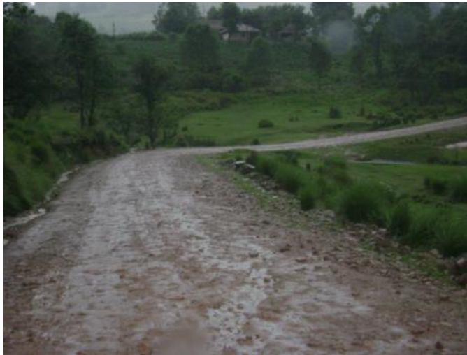
Figura 76. Tramo: San José Ojetenam a Concepción Tutuapa, estación 17+000
