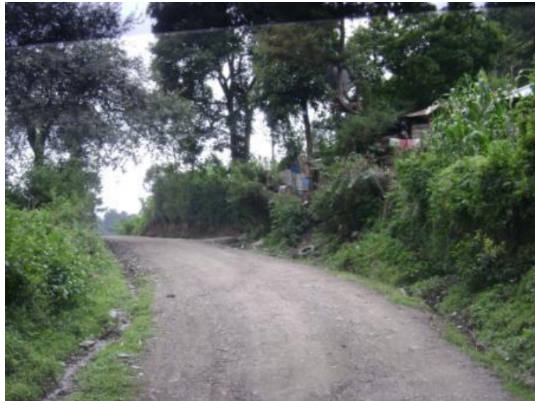
Figura 51. Tramo: Tacaná a San José Ojetenam, estación 7+000
