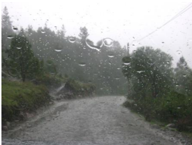
Figura 67. Tramo: San José Ojetenam a Concepción Tutuapa, estación 8+000
