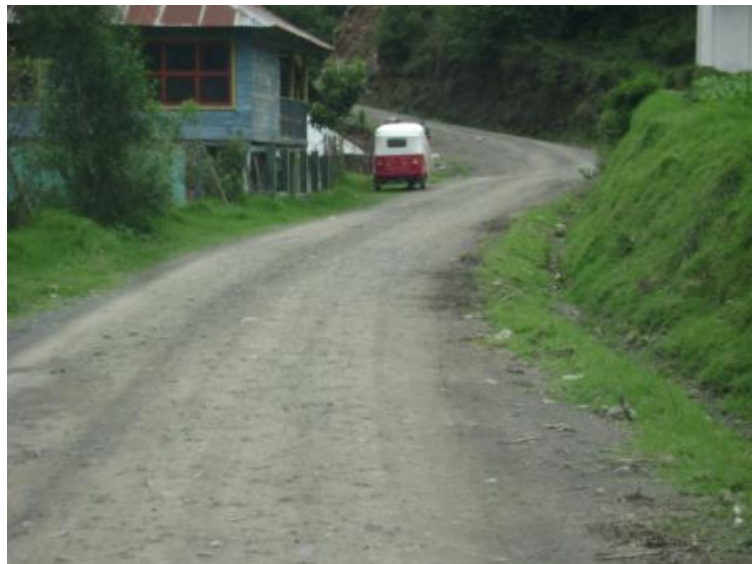
Figura 47. Tramo: Tacaná a San José Ojetenam, estación 3+000
