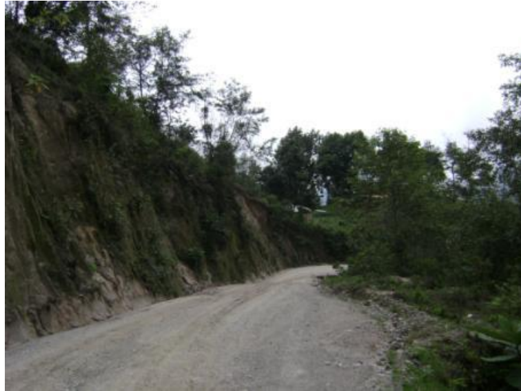
Figura 32. Tramo: Tacaná a frontera con México, estación 14+000
