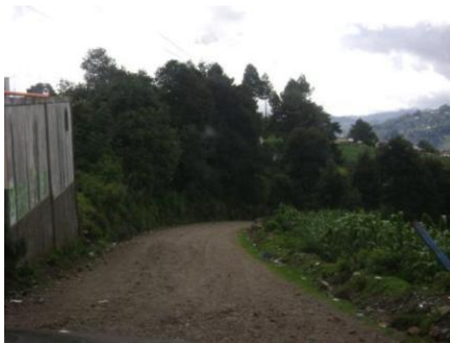
Figura 81. Tramo: Concepción Tutuapa a San Miguel Ixtahuacán, estación 0+000
