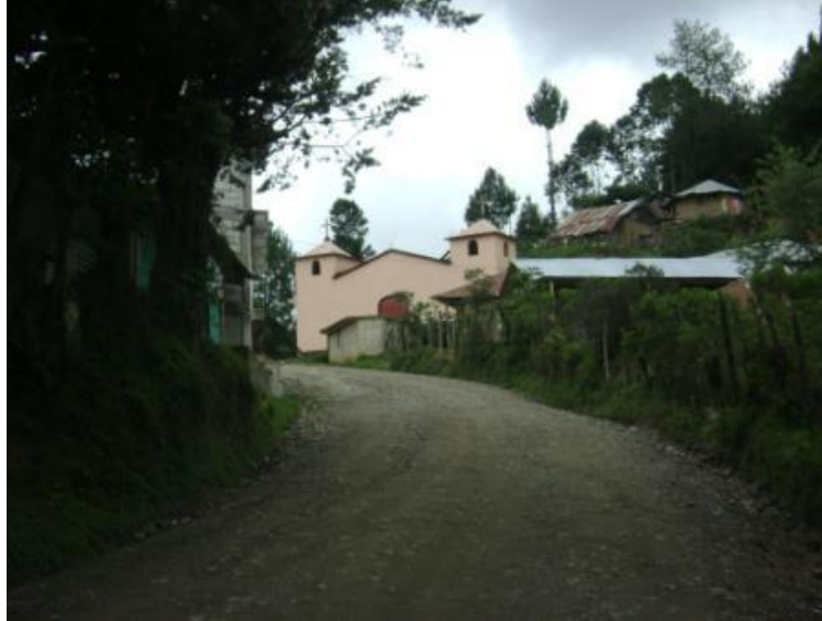
Figura 20. Tramo: Tacaná a frontera con México, estación 2+000
