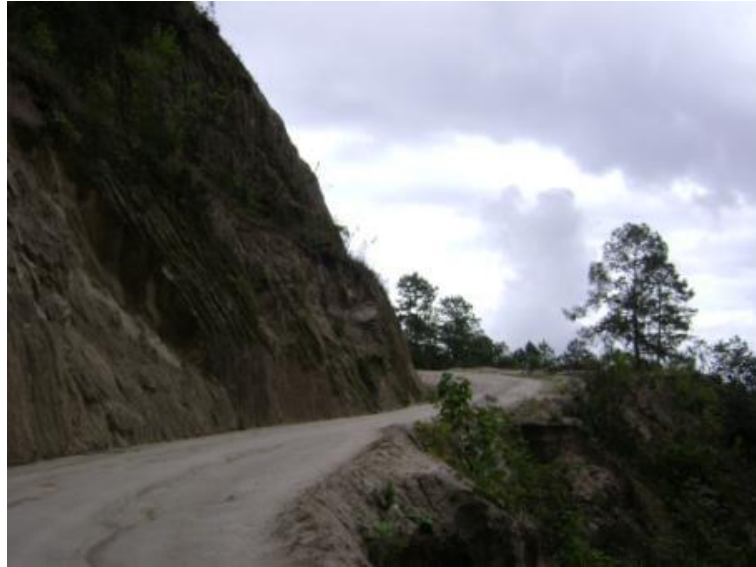
Figura 36. Tramo: Tacaná a frontera con México, estación 18+000
