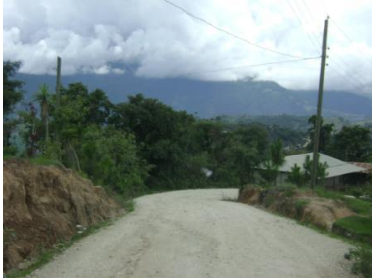
Figura 40. Tramo: Tacaná a frontera con México, estación 22+000
