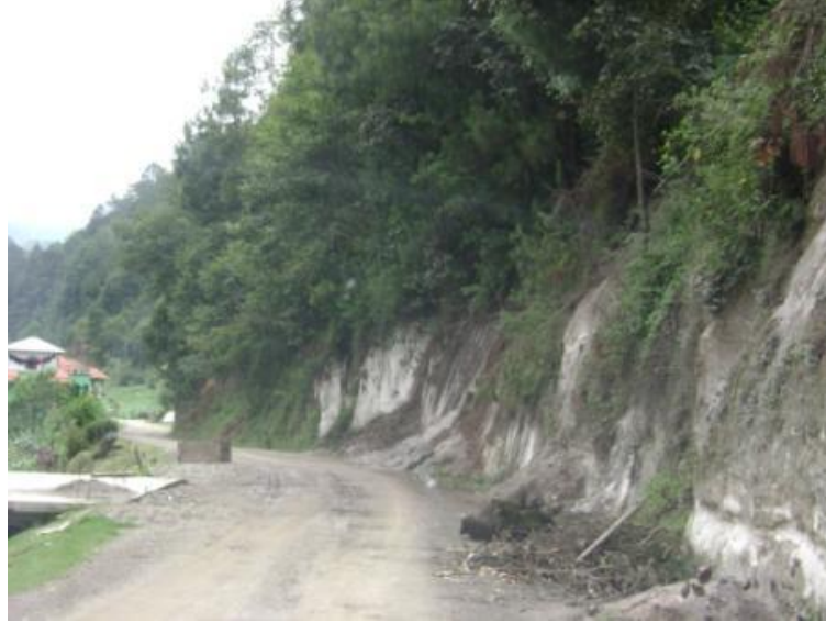
Figura 50. Tramo: Tacaná a San José Ojetenam, estación 6+000
