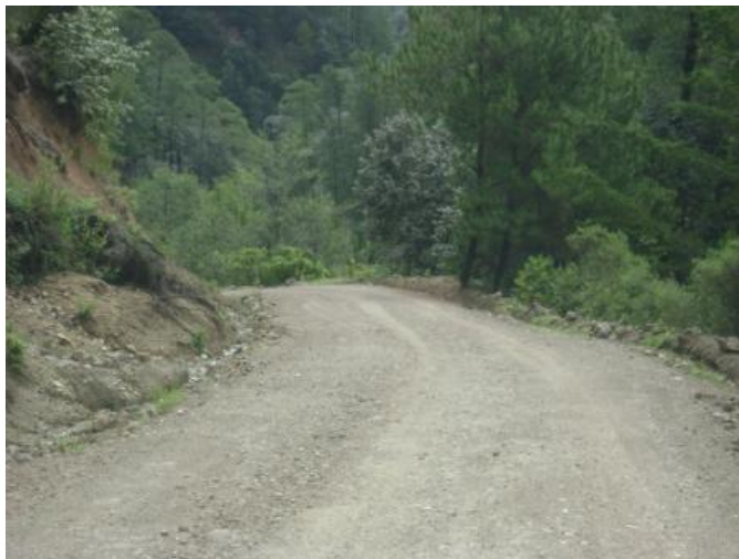
Figura 85. Tramo: Concepción Tutuapa a San Miguel Ixtahuacán, estación 4+000
