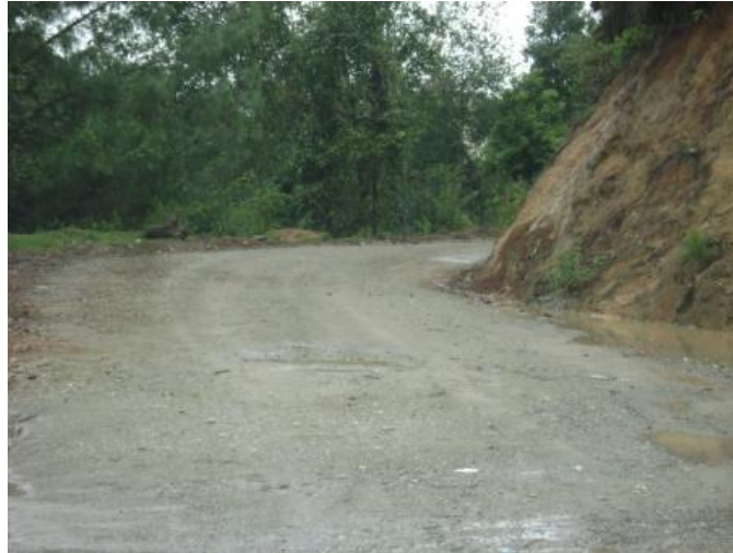
Figura 88. Tramo: Concepción Tutuapa a San Miguel Ixtahuacán, estación 7+000
