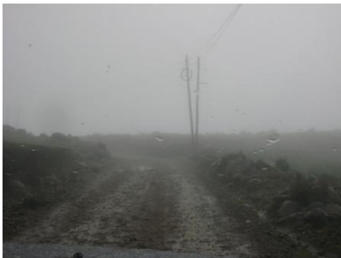
Figura 63. Tramo: San José Ojetenam a Concepción Tutuapa, estación 4+000
