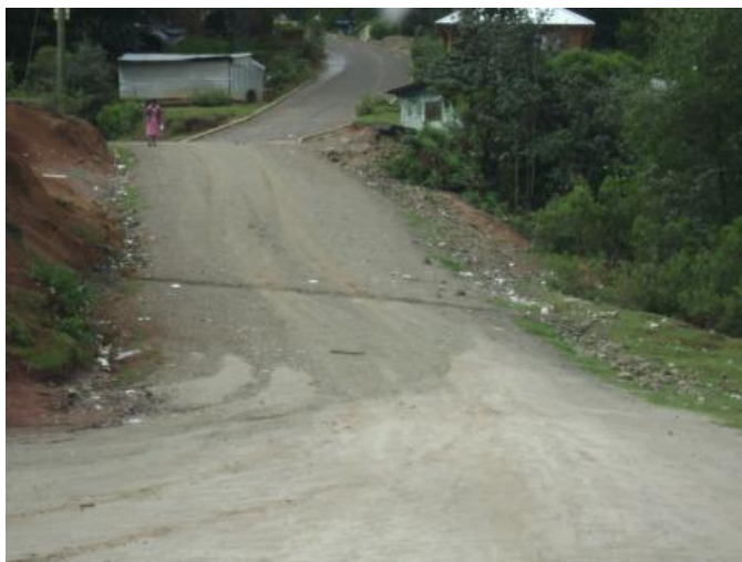
Figura 87. Tramo: Concepción Tutuapa a San Miguel Ixtahuacán, estación 6+000
