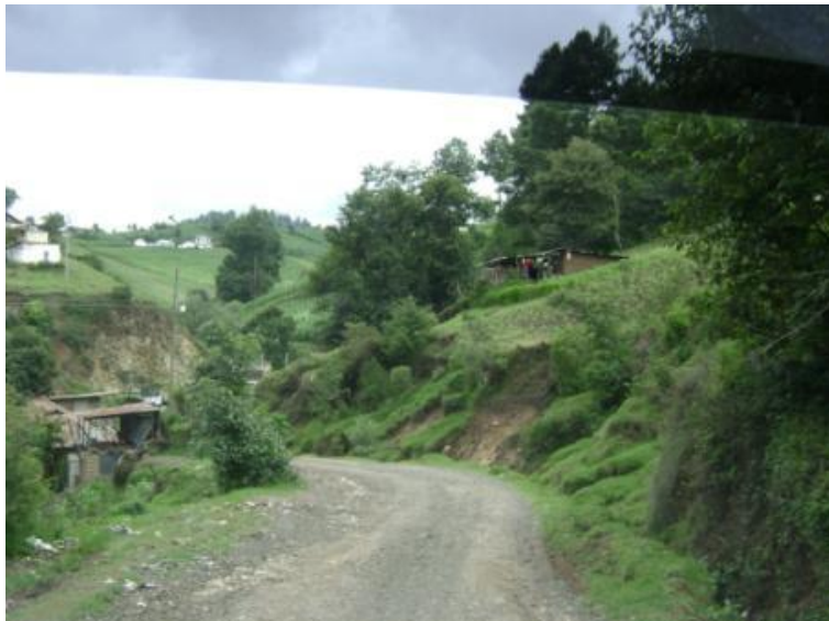
Figura 45. Tramo: Tacaná a San José Ojetenam, estación 1+000
