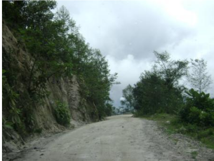
Figura 34. Tramo: Tacaná a frontera con México, estación 16+000
