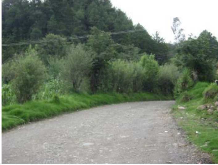
Figura 18. Tramo: Tacaná a frontera con México, estación 0+000
