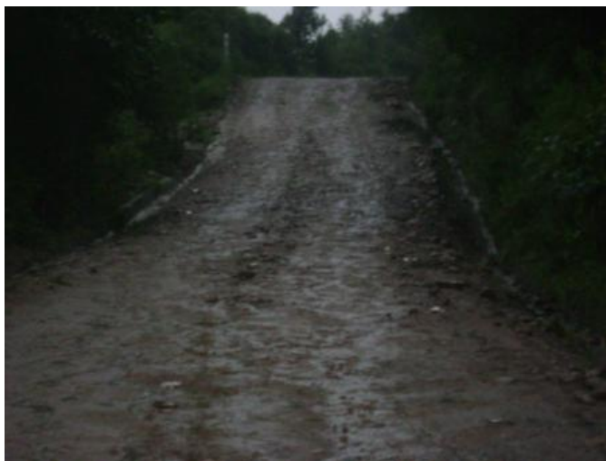
Figura 77. Tramo: San José Ojetenam a Concepción Tutuapa, estación 18+000
