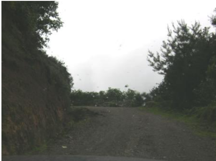
Figura 53. Tramo: Tacaná a San José Ojetenam, estación 9+000
