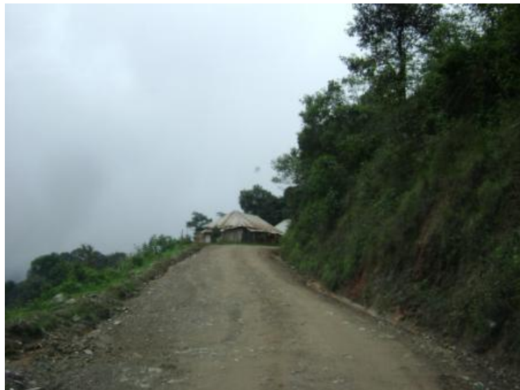
Figura 23. Tramo: Tacaná a frontera con México, estación 5+000
