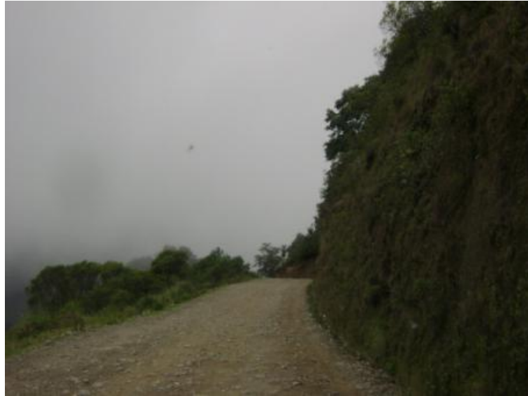
Figura 24. Tramo: Tacaná a frontera con México, estación 6+000
