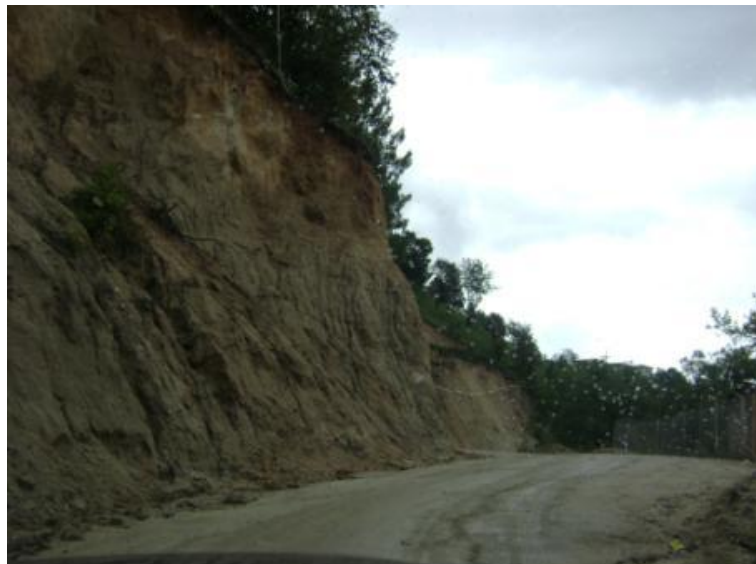
Figura 37. Tramo: Tacaná a frontera con México, estación 19+000
