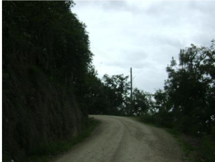
Figura 38. Tramo: Tacaná a frontera con México, estación 20+000
