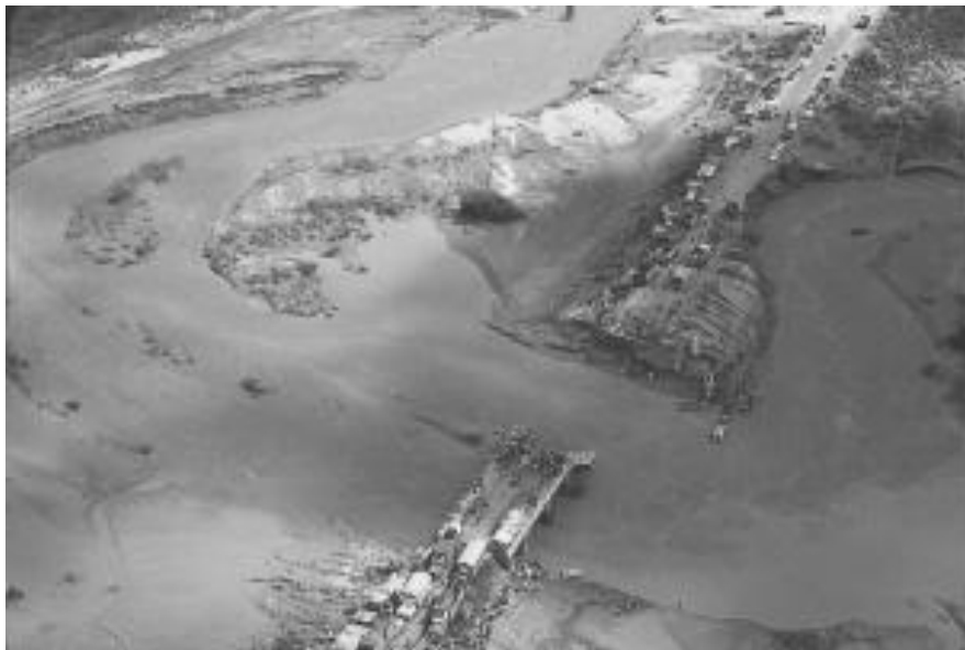
Figura 10. Efectos del clima en proyectos de infraestructura
