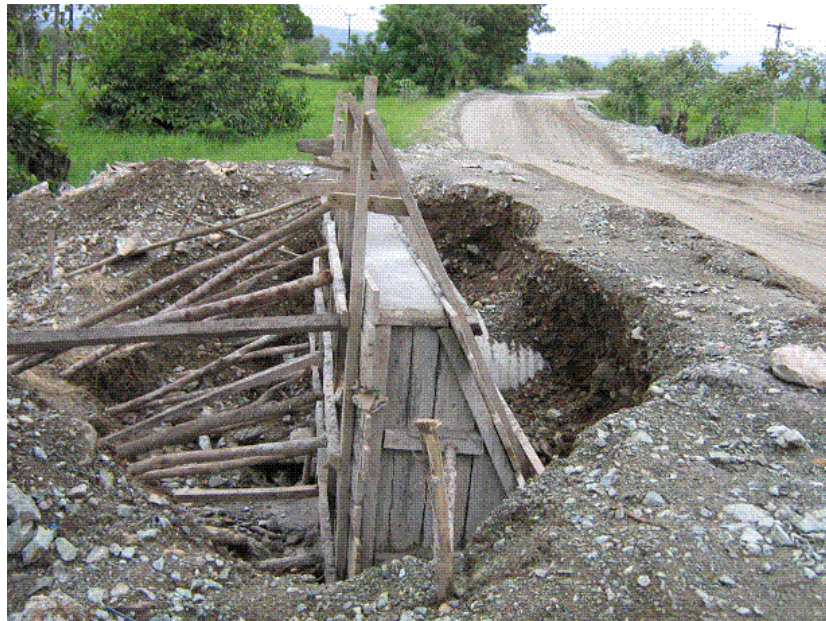
Figura 19. Construcción de muro
