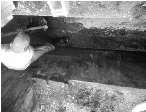
Figura 101. Limpieza de canal principal
