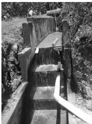
Figura 27. Punto de instalación de vertederos
