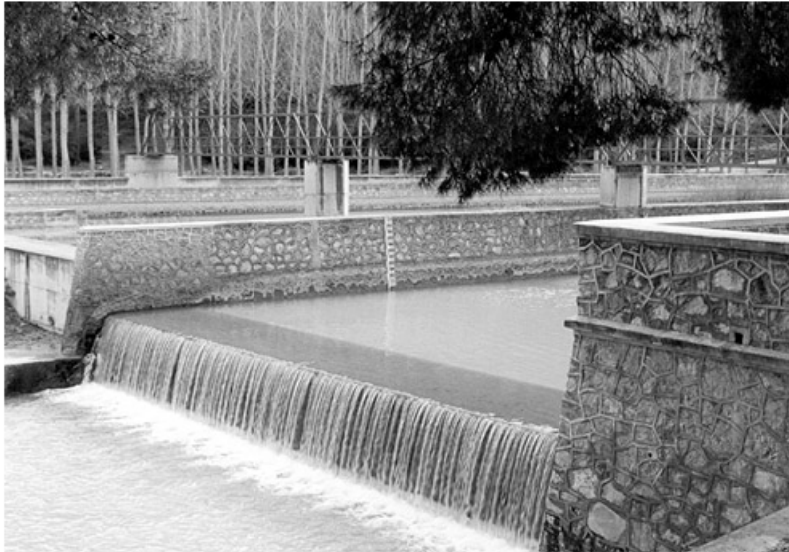
Figura 9. Vertedero fabricado con mampostería sobre río Segura, Murcia España
