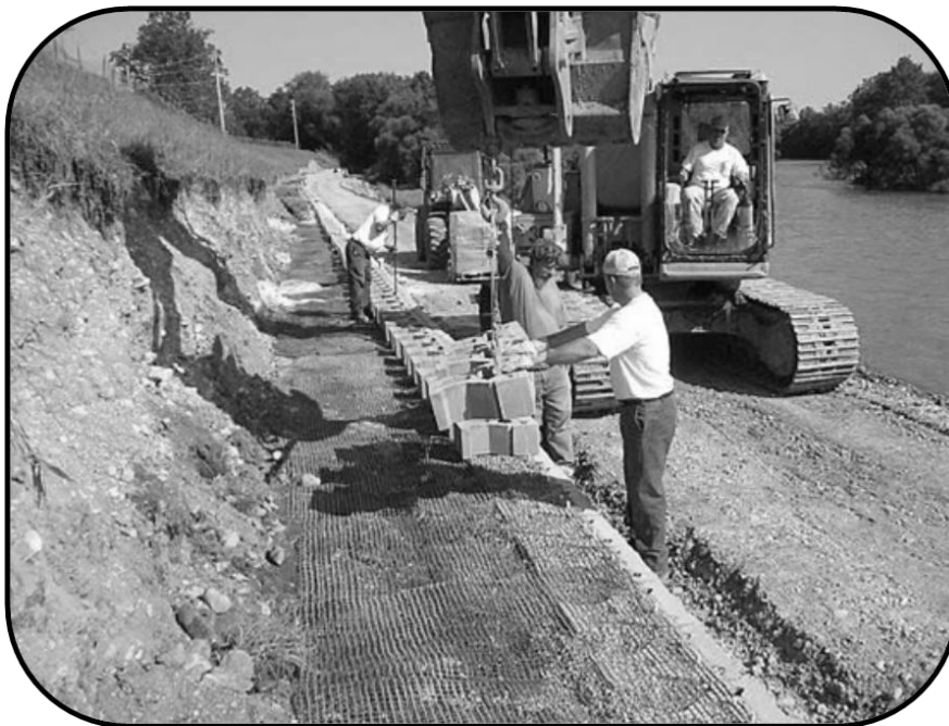
Figura 13. Armadura extensible con geomalla
