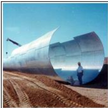
Figura 41. Tubería sección circular
