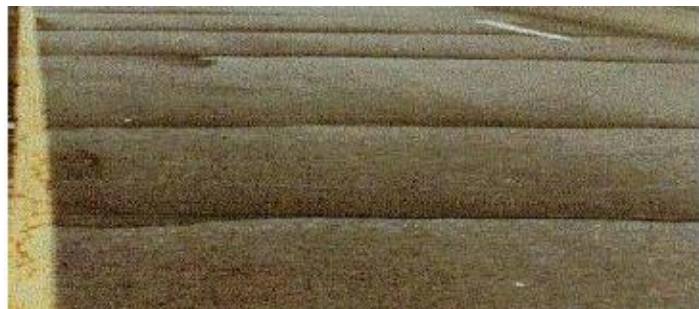
Figura 9. Corrugaciones severidad alta
