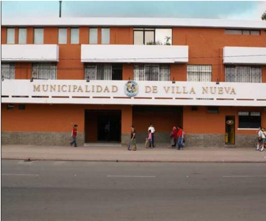
Figura 3. Municipalidad de Villa Nueva
