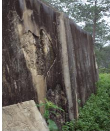
Figura 5. Muestra del estado actual del tanque
