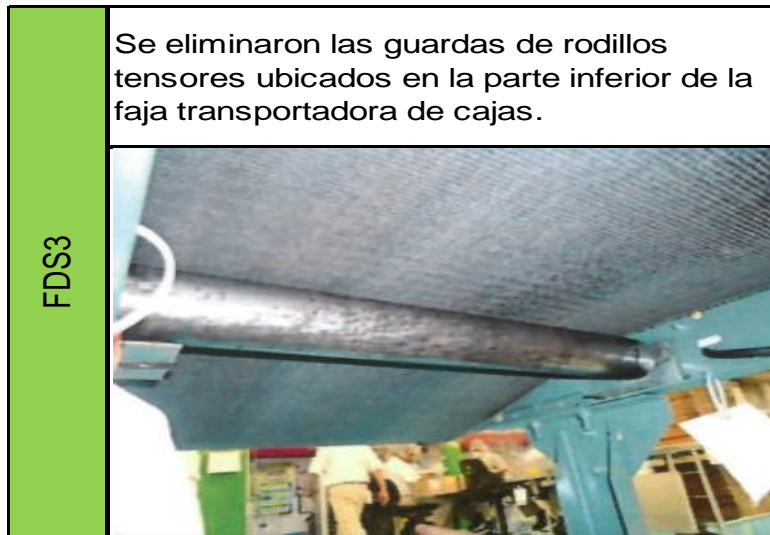
Figura 103. Mejora en fuente de suciedad # 3 de línea 1
