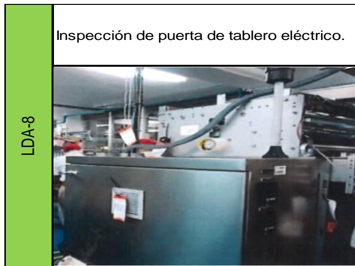
Figura 26. Lugar de difícil acceso a inspección # 1 de línea 1
