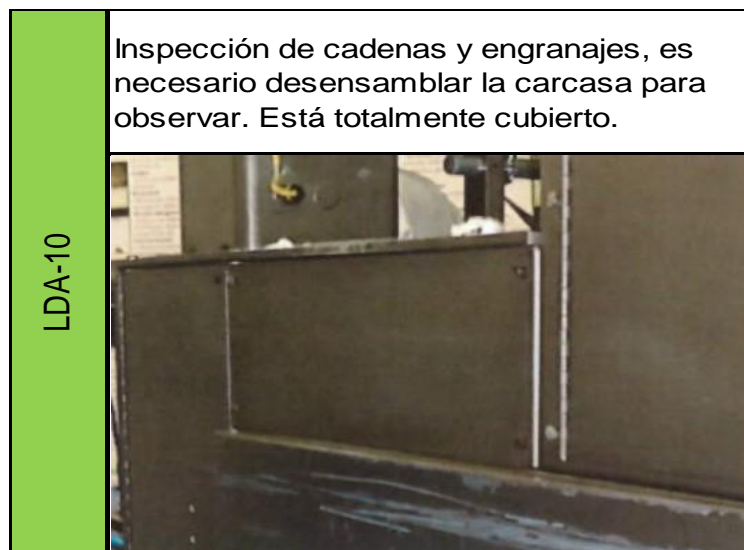
Figura 28. Lugar de difícil acceso a inspección # 3 de línea 1
