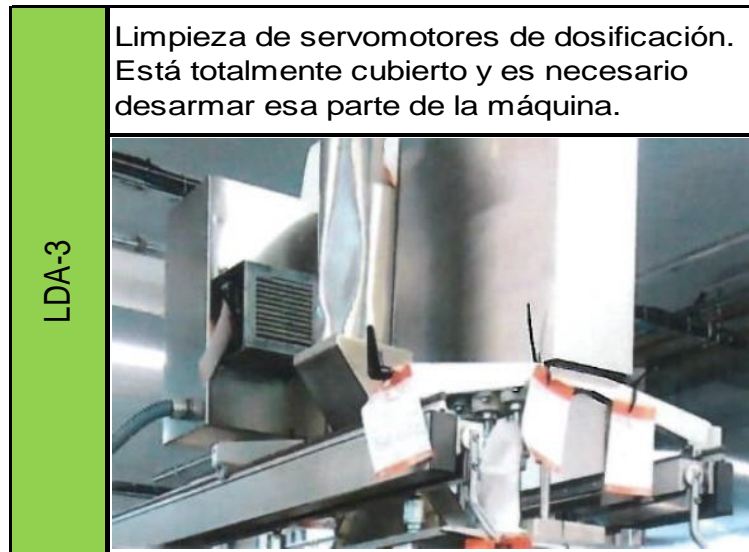
Figura 21. Lugar de difícil acceso a limpieza # 3 de línea 1
