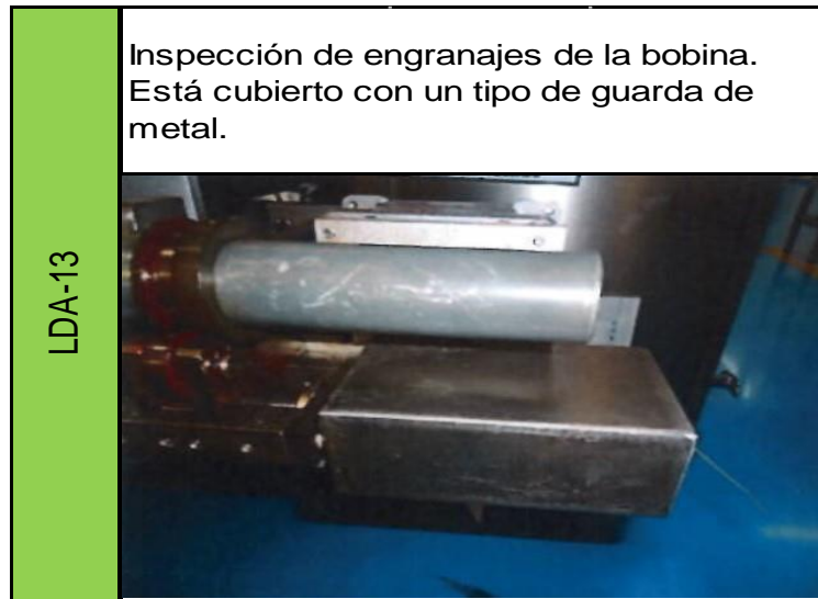
Figura 31. Lugar de difícil acceso a inspección # 6 de línea 1
