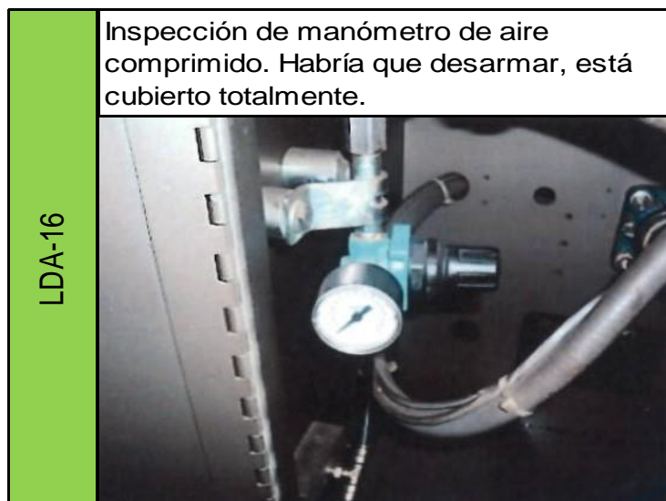
Figura 34. Lugar de difícil acceso a inspección # 9 de línea 1
