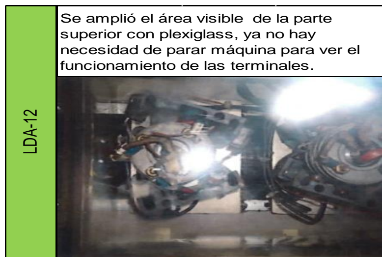
Figura 122. Mejora en lugar de difícil acceso a inspección # 5 de línea 1
