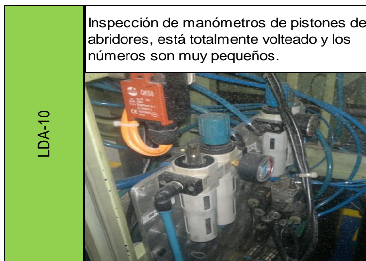
Figura 56. Lugar de difícil acceso a inspección # 3 de línea 2
