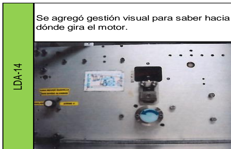
Figura 124. Mejora en lugar de difícil acceso a inspección # 7 de línea 1
