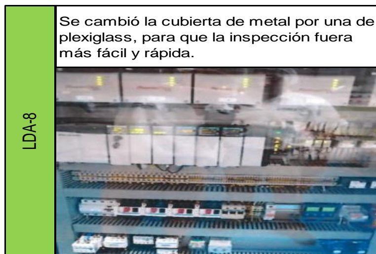
Figura 118. Mejora en lugar de difícil acceso a inspección # 1 de línea 1
