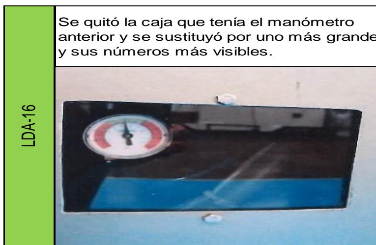
Figura 126. Mejora en lugar de difícil acceso a inspección # 9 de línea 1
