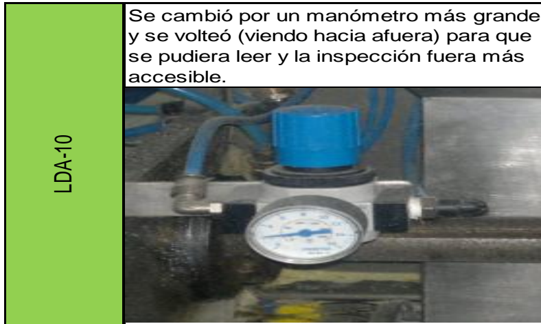
Figura 141. Mejora en lugar de difícil acceso a inspección # 3 de línea 2
