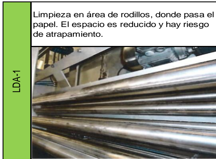
Figura 19. Lugar de difícil acceso a limpieza # 1 de línea 1
