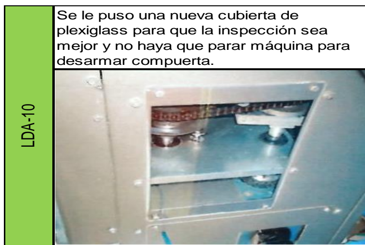
Figura 120. Mejora en lugar de difícil acceso a inspección # 3 de línea 1
