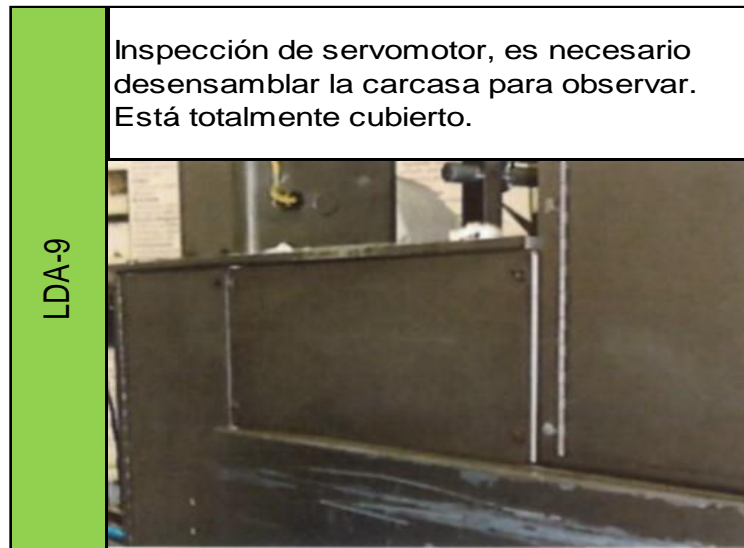
Figura 27. Lugar de difícil acceso a inspección # 2 de línea 1
