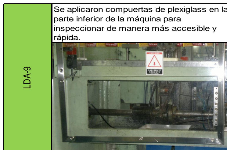
Figura 140. Mejora en lugar de difícil acceso a inspección # 2 de línea 2
