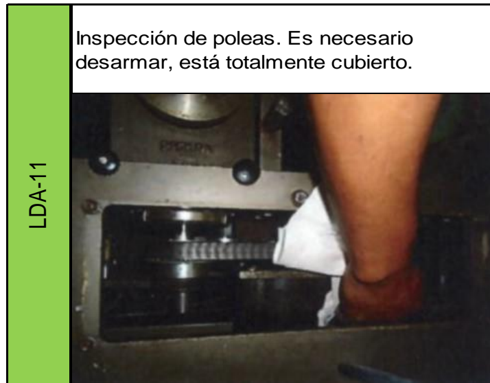
Figura 29. Lugar de difícil acceso a inspección # 4 de línea 1
