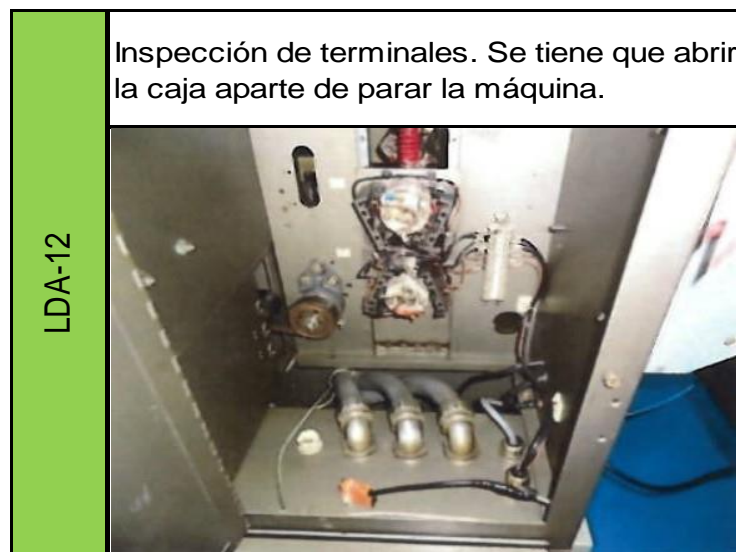
Figura 30. Lugar de difícil acceso a inspección # 5 de línea 1
