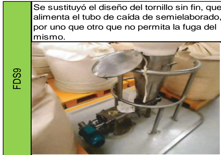
Figura 109. Mejora en fuente de suciedad # 9 de línea 1
