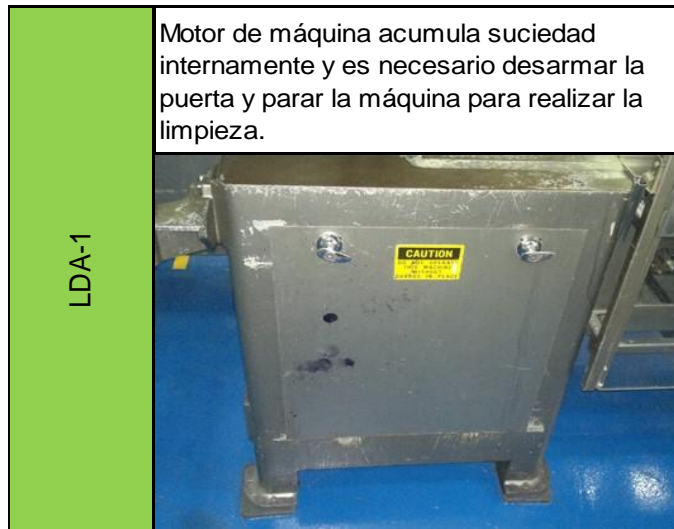
Figura 47. Lugar de difícil acceso a limpieza # 1 de línea 2
