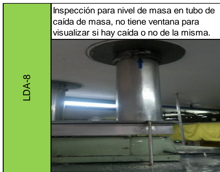
Figura 54. Lugar de difícil acceso a inspección # 1 de línea 2
