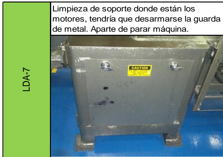
Figura 53. Lugar de difícil acceso a limpieza # 7 de línea 2
