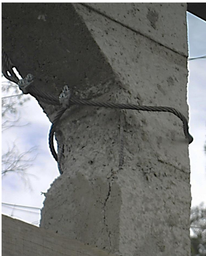
Figura 57. Falla por compresión
