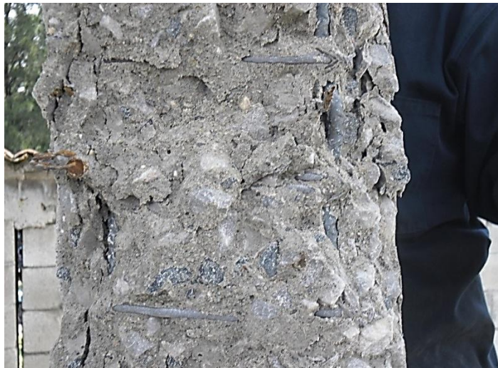
Figura 74. Falla de compresión
