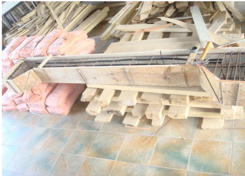
Figura 43. Columna con cable
