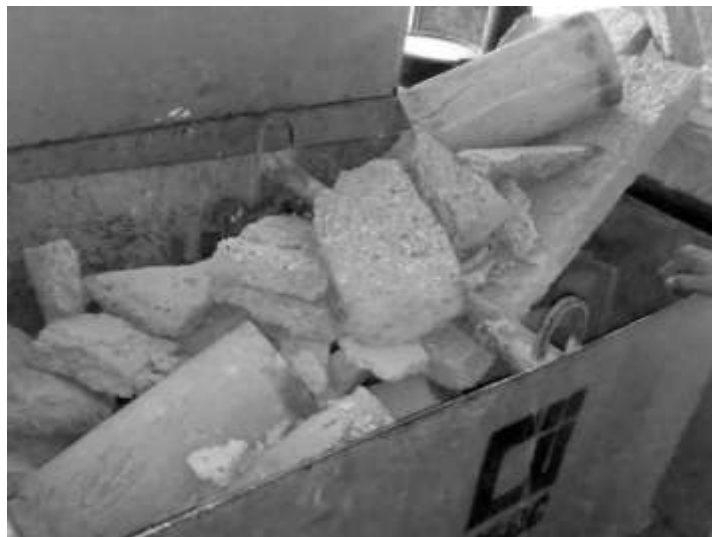
Figura 16. Limpieza del área de trabajo
