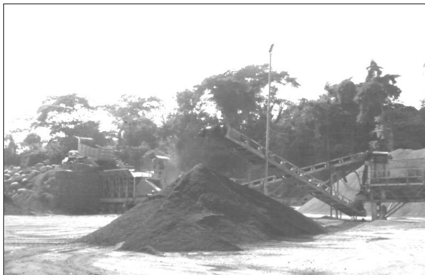
Figura 8. Fotografía de planta trituradora en río, Coyolate, carretera CA-2, km 107
