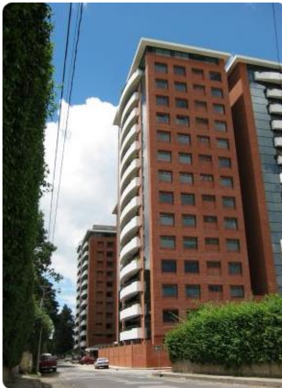
Figura 5. Uso de ladrillo expuesto en edificio
