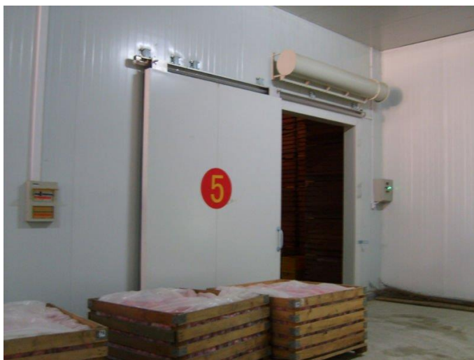
Figura 19. Ingreso al área de cuarto frío
