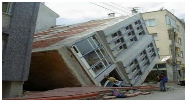
Figura 39. Construcción volcada debido a licuefacción
