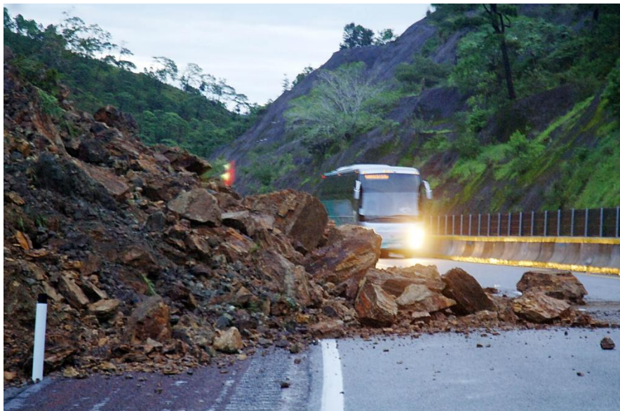
Figura 37. Carretera bloqueada por derrumbe en ruta Interamericana
