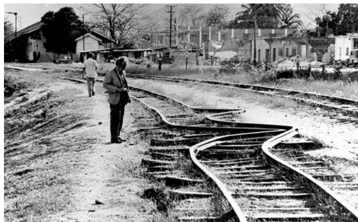
Figura 29. Destrucción de línea férrea en toda Guatemala por el terremoto de 1976. Foto de zona 1 capitalina, barrio Gerona
