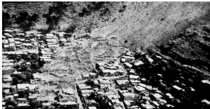
Figura 36. Deslizamiento de un cerro sobre un caserío en una provincia de Venezuela
