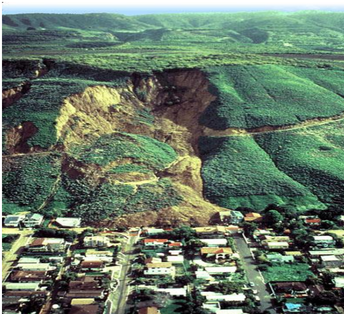
Figura 34. Deslizamiento de una ladera
