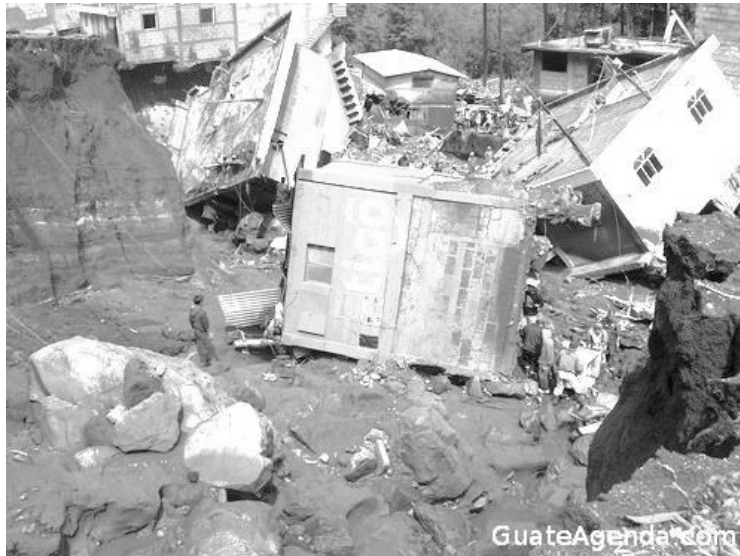
Figura 12. Colapso de viviendas en pueblos
