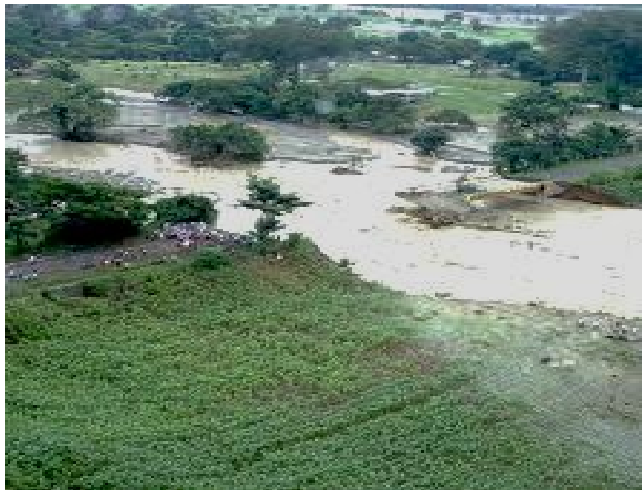
Figura 11. Colapso de puente vehicular por crecida de río
